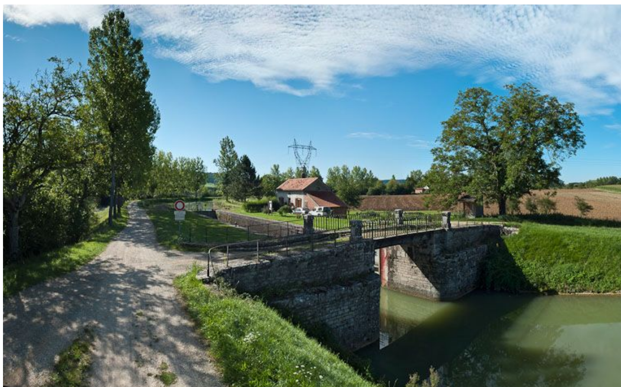
Vue d'ensemble du site d'écluse.
