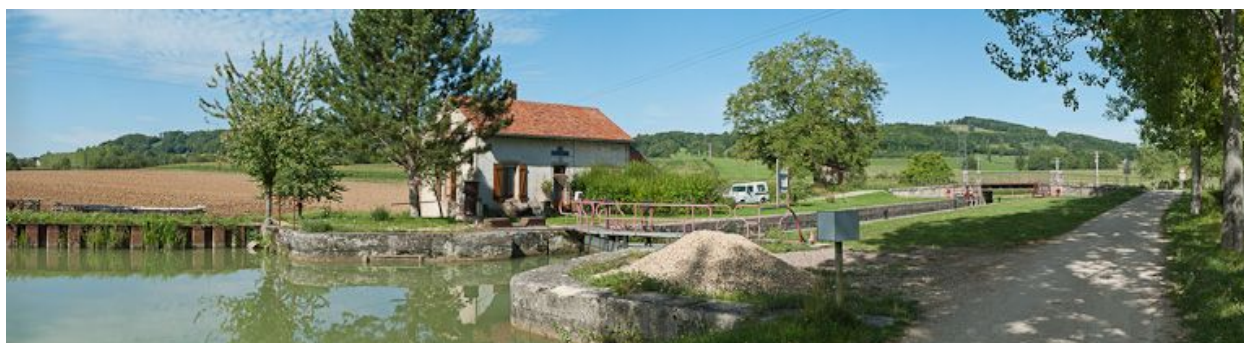
Vue d'ensemble du site d'écluse.
