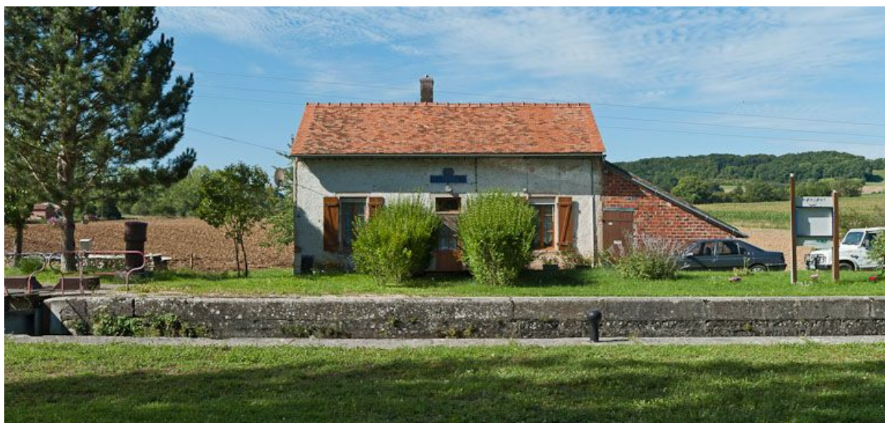
Vue de face de la maison éclusière.
