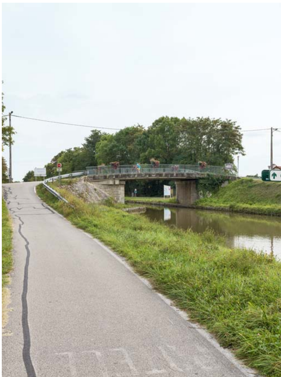
Vue d'ensemble du pont.
