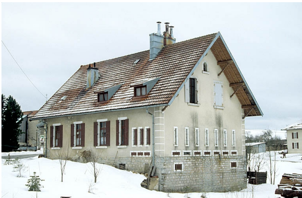
Façades postérieure et latérale droite.
