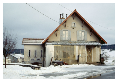
Façade antérieure. Phot. Laurent Poupard IVR43_19923901168ZA
