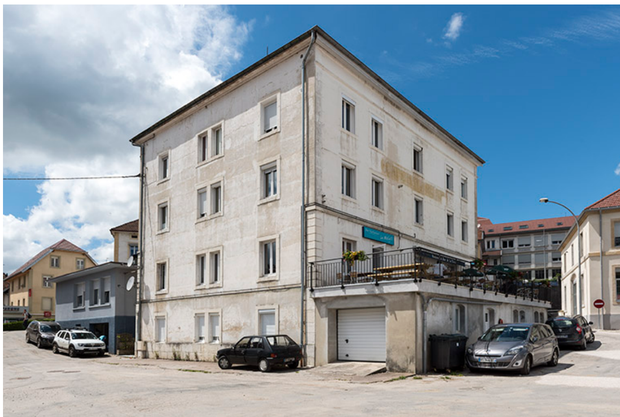
Immeuble : façades postérieure et latérale gauche.
