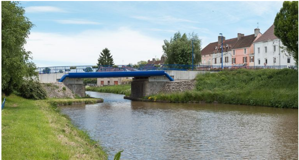
Le pont, vu d'aval.
