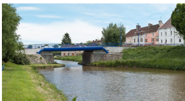
Le pont, vu d'aval. Phot. Pierre-Marie Barbe-Richaud IVR26_20137100412NUC2AQ
