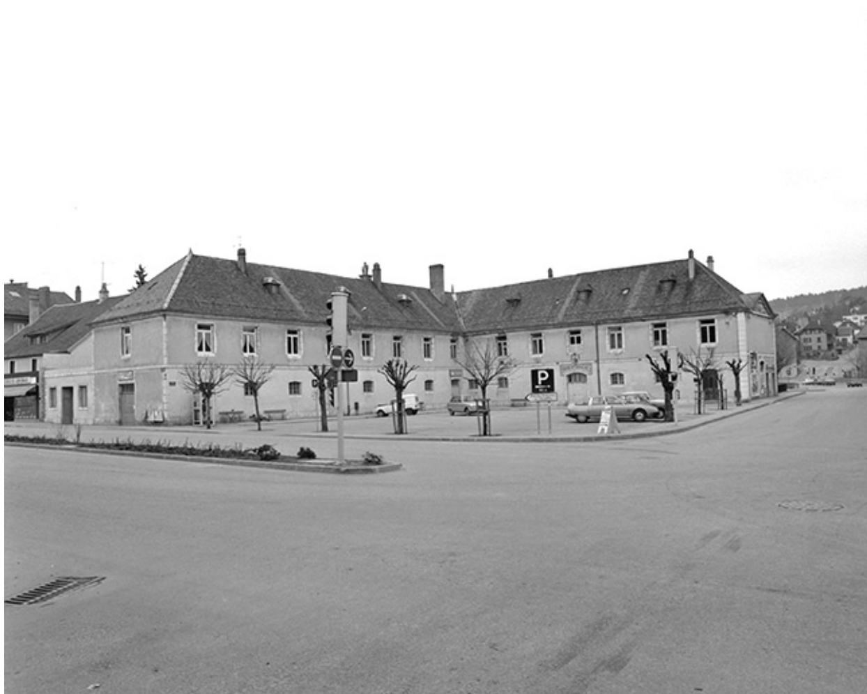
Corps de bâtiment gauche.
