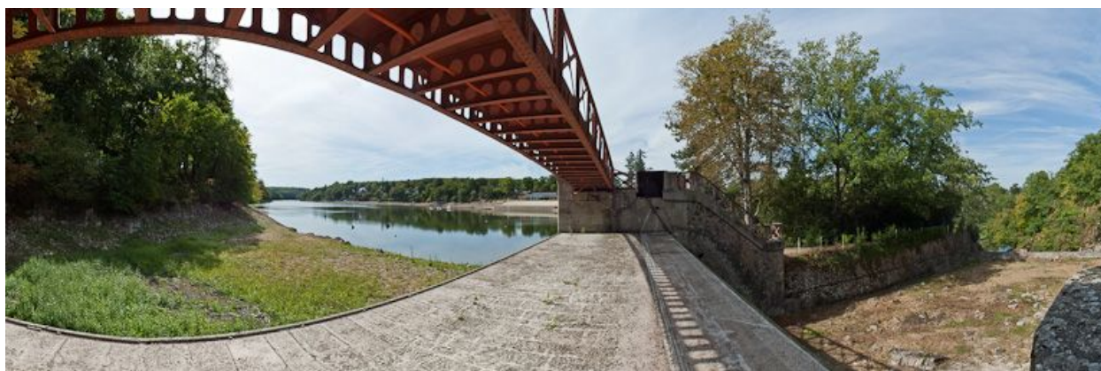
Vue du déversoir.
