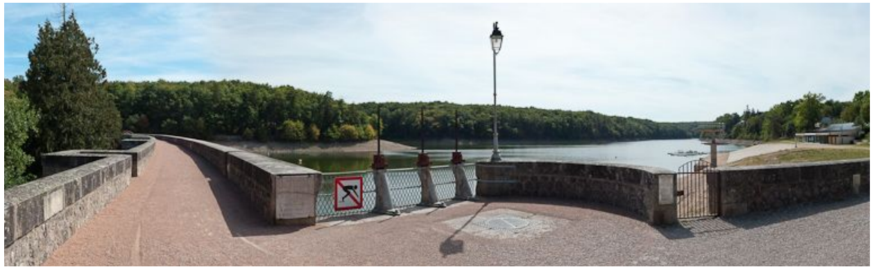
Vue d'ensemble du réservoir.
