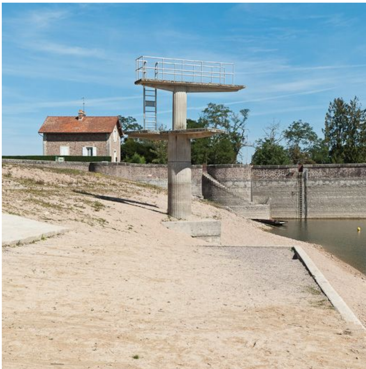
Vue du plongoir.
