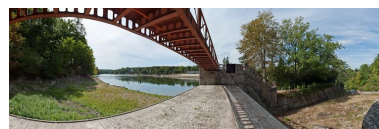
Vue du déversoir. Phot. Pierre-Marie Barbe-Richaud IVR26_20112103630NUC4AQ
