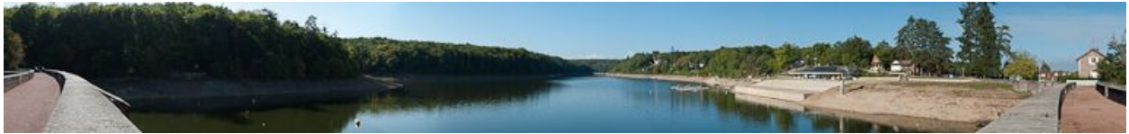
Vue d'ensemble du réservoir.
