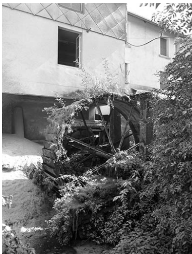
Roue hydraulique sur la façade postérieure.
