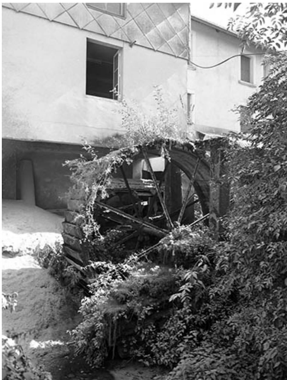
Roue hydraulique sur la façade postérieure.
