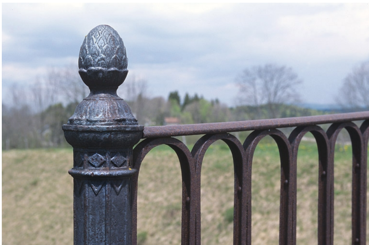
Motif d'amortissement d'un potelet du garde-corps.
