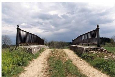
Tablier en dos-d'âne. Phot. Yves Sancey IVR43_20053900256ZA
