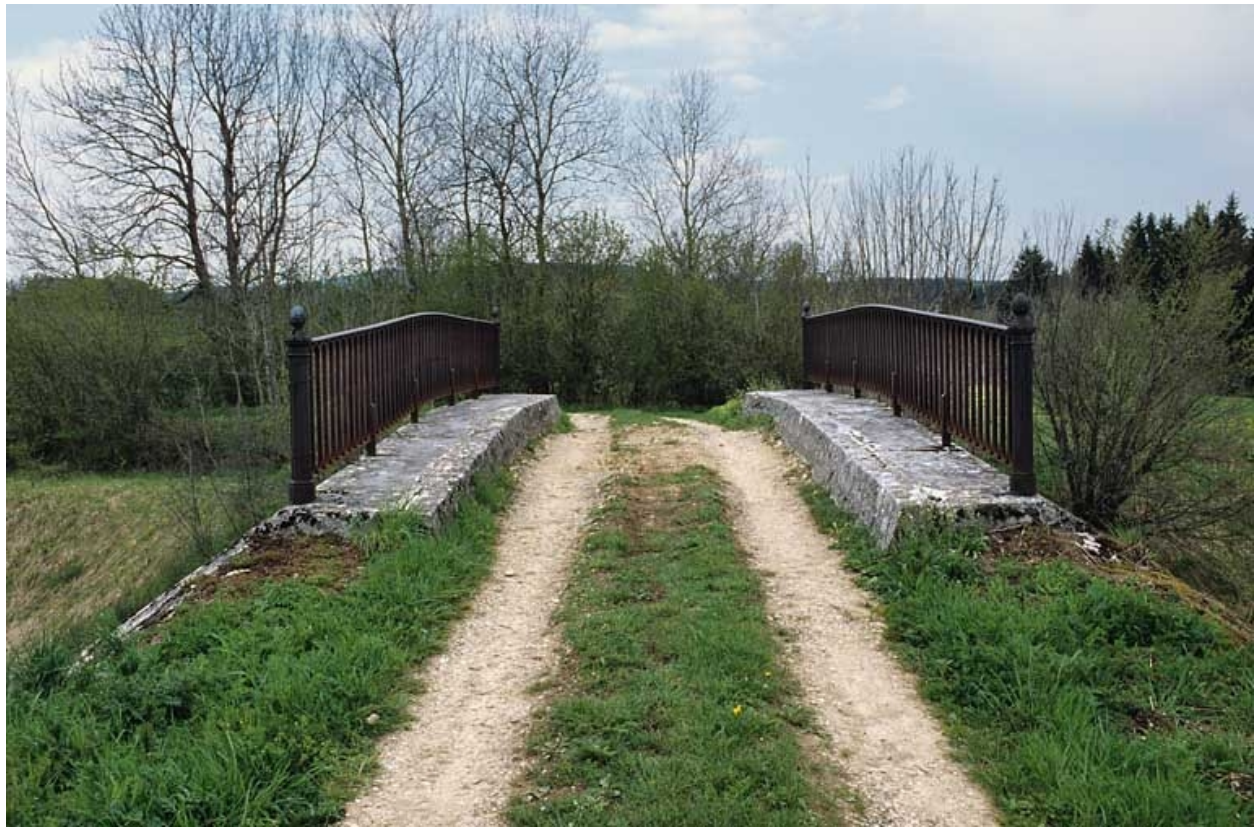
Vue d'ensemble du tablier.
