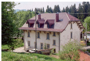
Façade postérieure. Phot. Yves Sancey IVR43_19993900070ZA
