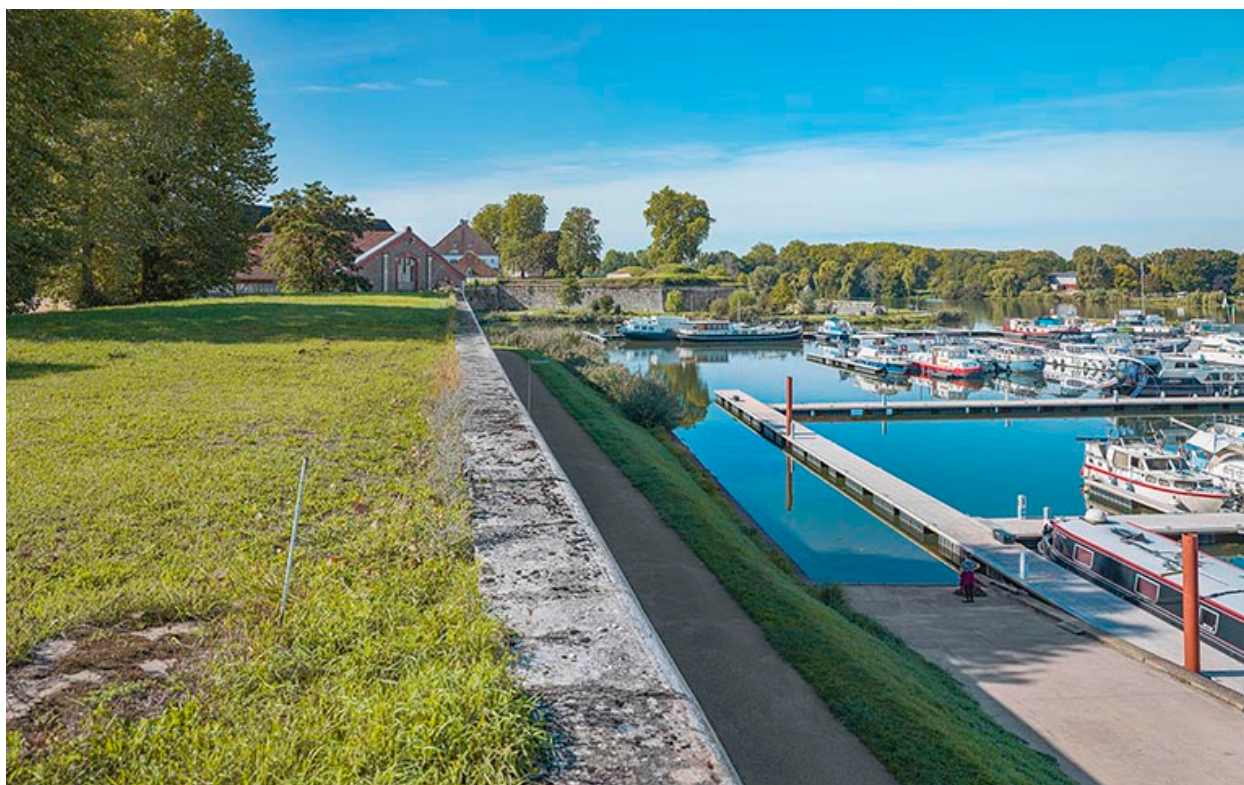
Terre-plein, parapet (face ouest).
