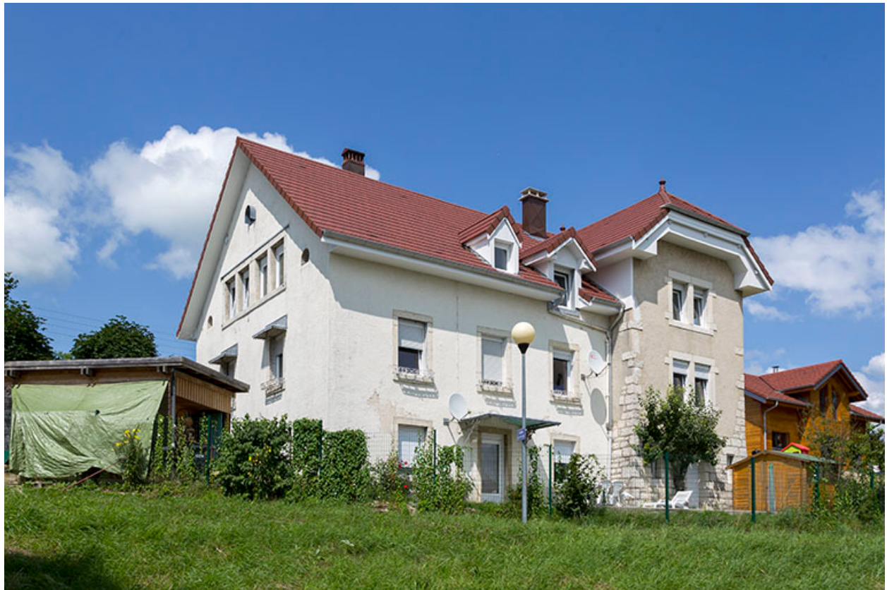
Façades postérieure et latérale droite.
