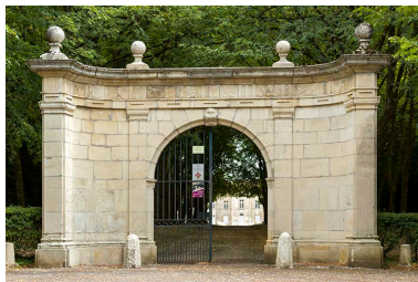
Portail à l'entrée du parc. Phot. Sonia Dourlot IVR43_20157001576NUC2A
