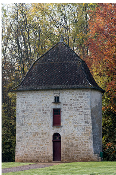
La tour tranchée. Phot. Sonia Dourlot IVR43_20157001584NUC2A
