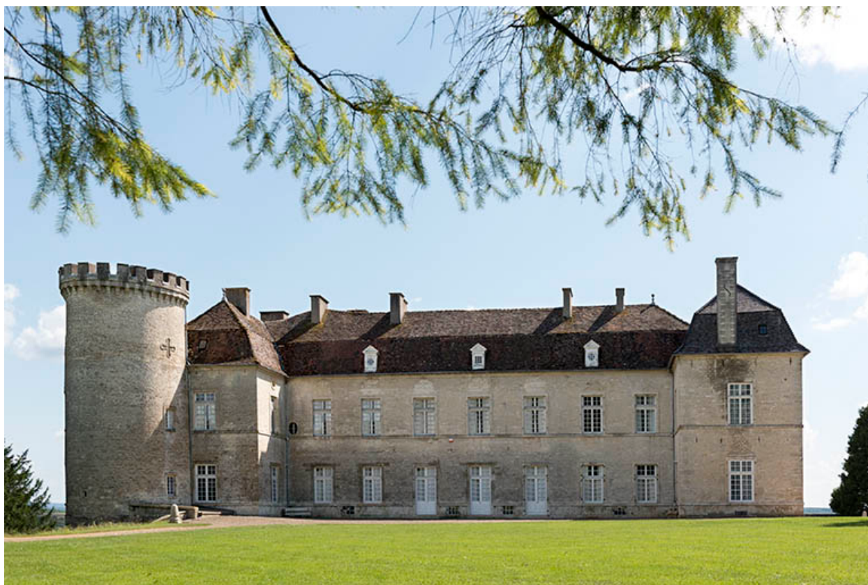
Vue générale de la façade nord.
