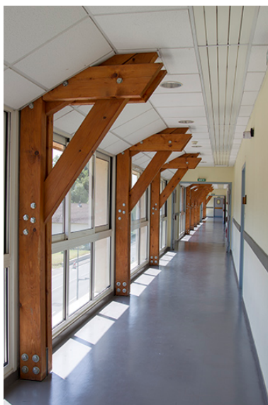
Détail de circulation intérieure de l'externat nord-est.
