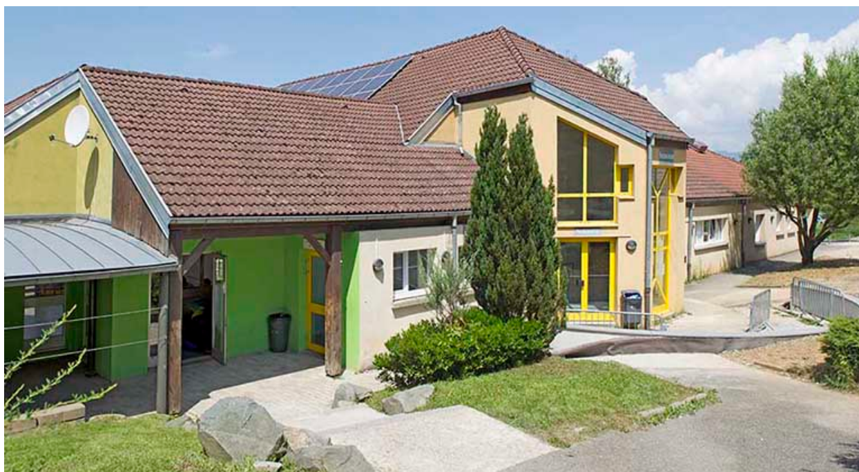
Angle sud-est de la restauration.
