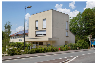
Angle sud-est de l'administration et des logements. Phot. Jérôme Mongreville IVR43_20149000164NUC2A
