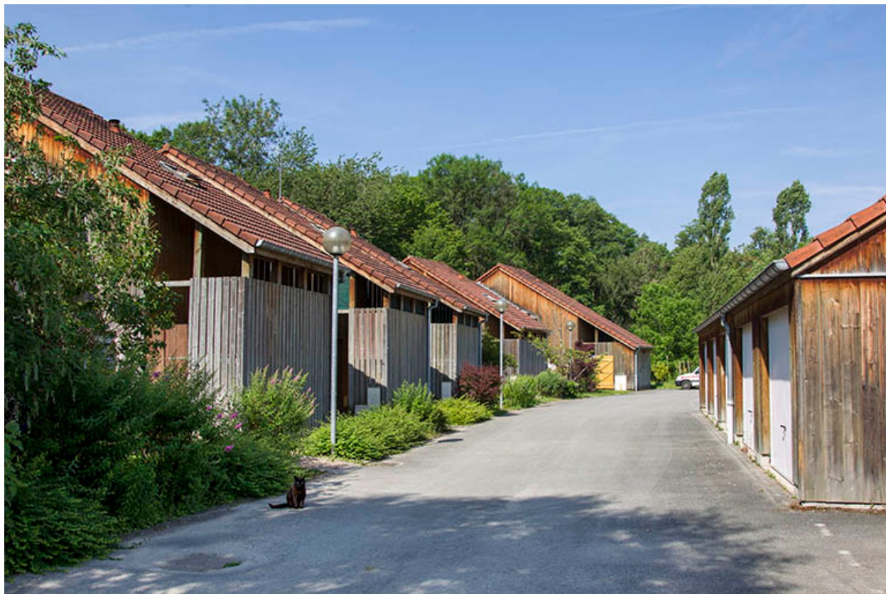
Façades nord des logements du site d'exploitation.
