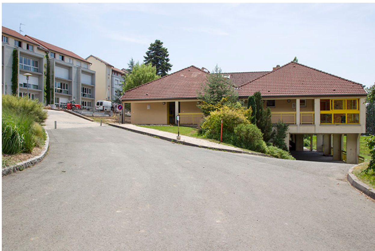
Façade nord de la restauration.
