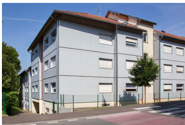
Pignon sud de l'internat, angle sud-est. Phot. Jérôme Mongreville IVR43_20149000188NUC2A
