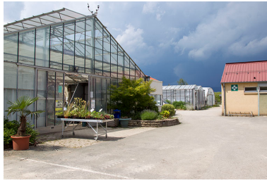
Pignon est de la serre magasin. Phot. Jérôme Mongreville IVR43_20149000203NUC2A
