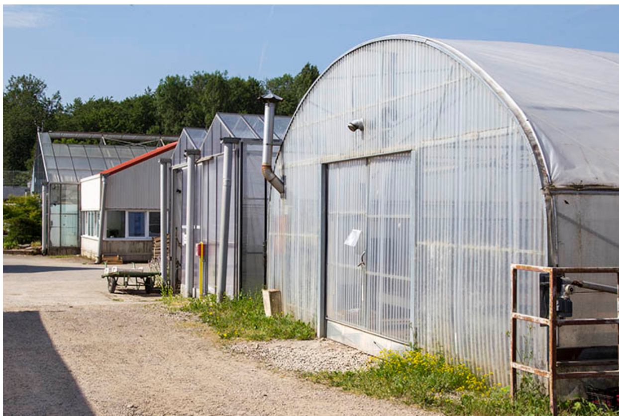
Serres au nord-ouest vues du nord-est.
