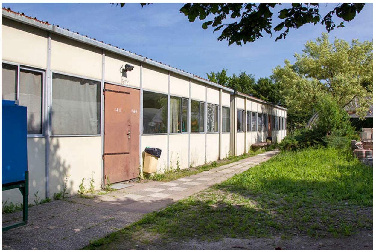
Façade postérieure des salles de cours nord-est.
