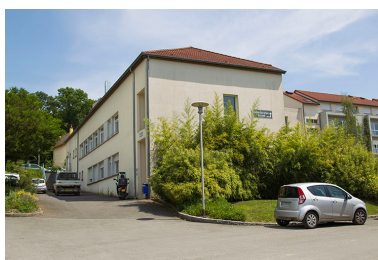
Angle nord-ouest de l'administration et des logements.
