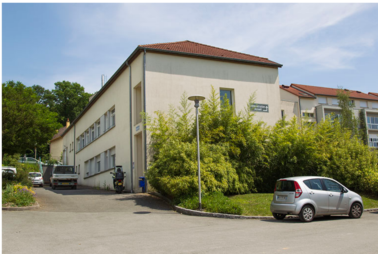
Angle nord-ouest de l'administration et des logements.
