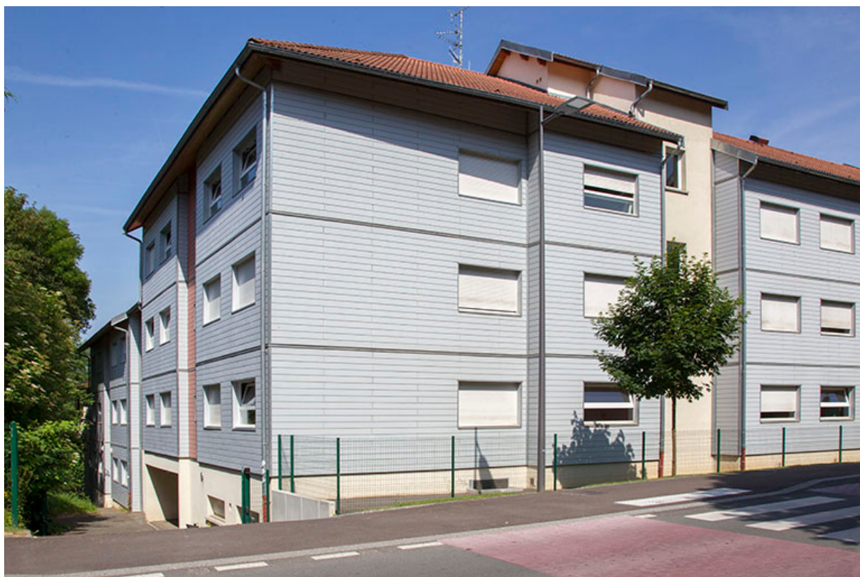
Pignon sud de l'internat, angle sud-est.
