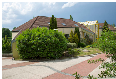
Angle sud-est de l'externat sud-ouest. Phot. Jérôme Mongreville IVR43_20149000169NUC2A
