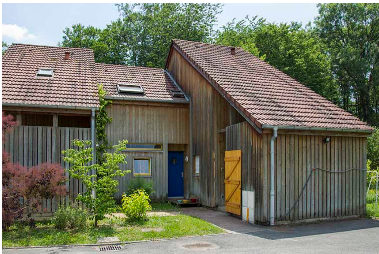
Détail de logement du site d'exploitation.
