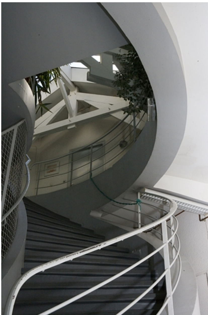
Quatrième volée et charpente de la cage d'escalier.
