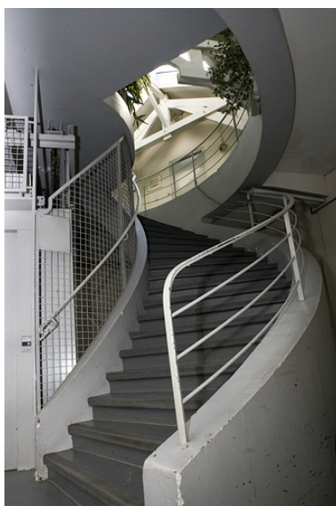
Volée d'escalier du quatrième étage. Phot. Yves Sancey IVR43_20062500605NUCA
