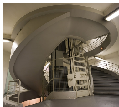
Escalier à double révolution. Phot. Yves Sancey IVR43_20062500611NUCA
