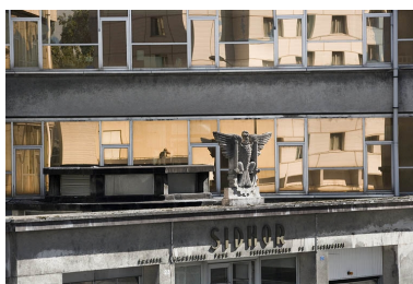
Détail de la façade, vue de trois quarts gauche. Phot. Yves Sancey IVR43_20062500596NUCA
