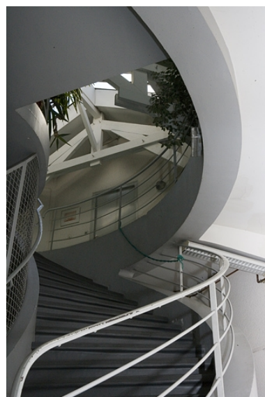
Quatrième volée et charpente de la cage d'escalier. Phot. Yves Sancey IVR43_20062500606NUCA
