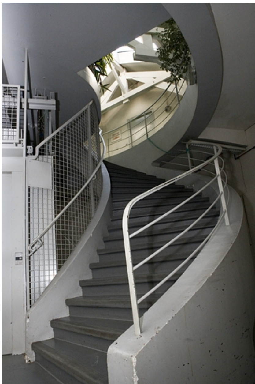
Volée d'escalier du quatrième étage.
