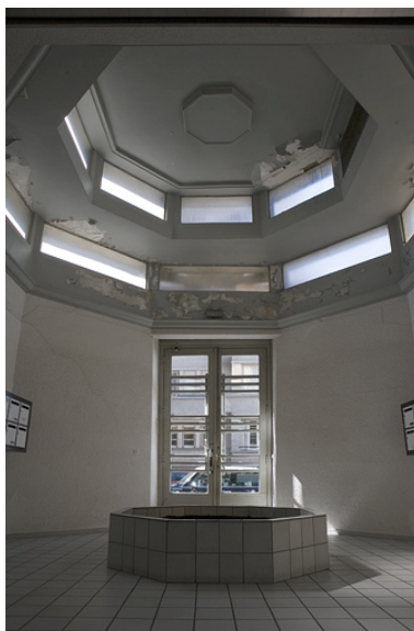
Vestibule au rez-de-chaussée. Phot. Yves Sancey IVR43_20062500602NUCA
