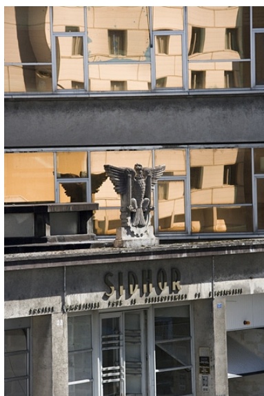
Détail de la façade, vue de trois quarts gauche (cadrage vertical). Phot. Yves Sancey IVR43_20062500597NUCA
