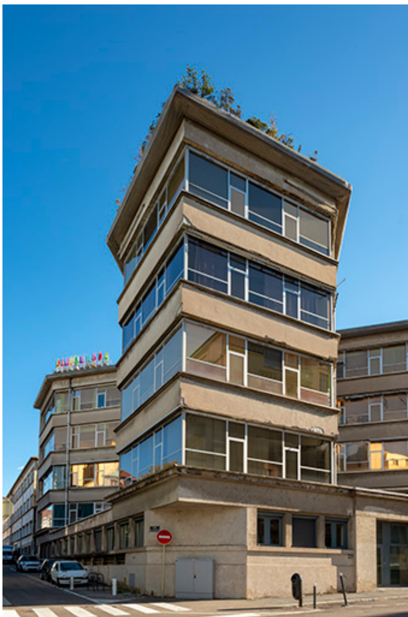
Vue d'ensemble depuis l'ouest.
