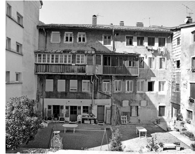
Bâtiment au n° 23 : élévation côté Bienne. Phot. Yves Sancey IVR43_20033900450X
