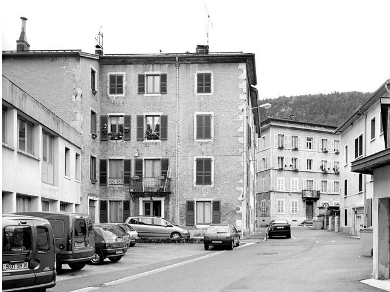
Bâtiment au n° 21, vu du nord.
