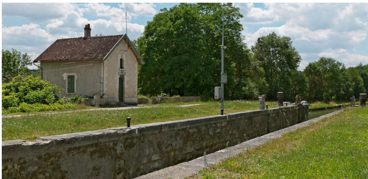
Vue d'ensemble du site d'écluse.
