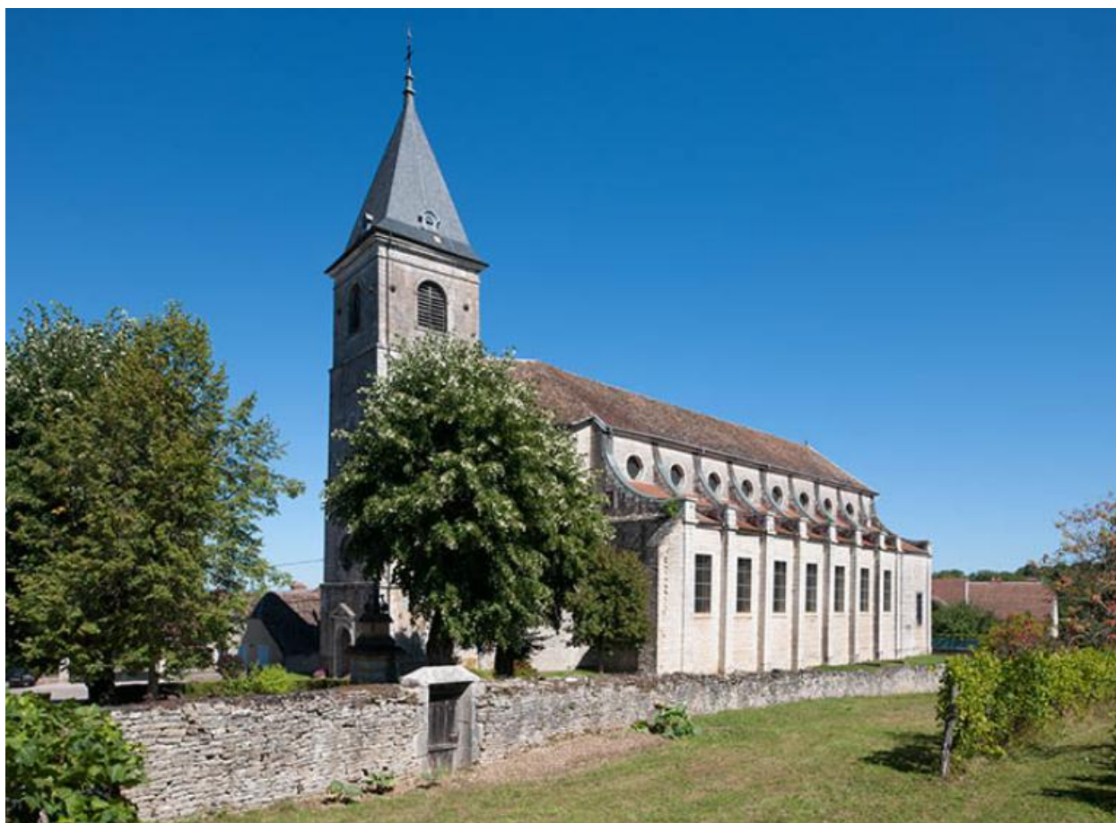
Vue générale sud-ouest de l'église
