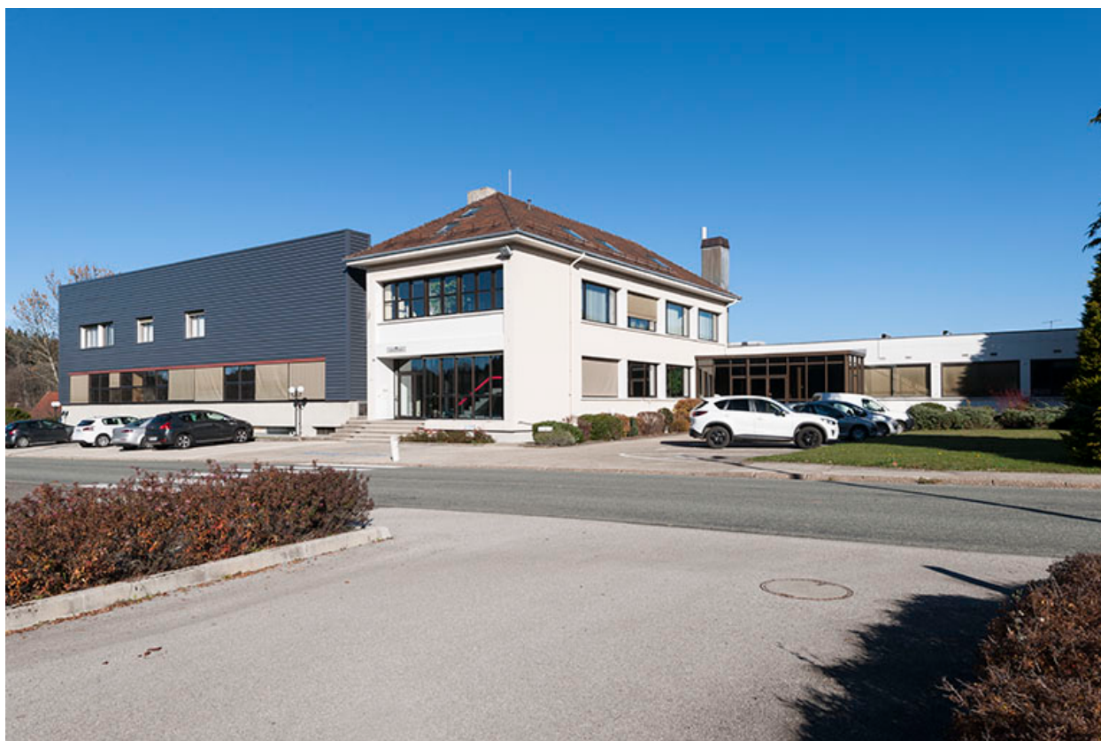
Façade antérieure, de trois quart droite.
