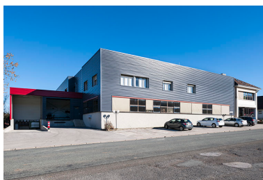
Façade antérieure : ateliers ouest. Phot. Jérôme Mongreville IVR43_20152502238NUC4A
