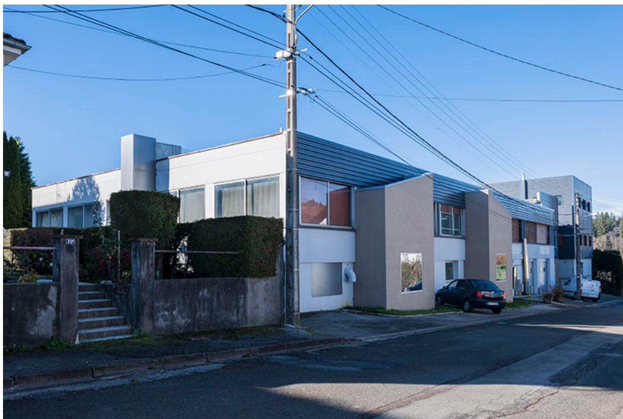
Façades postérieure et latérale droite.
