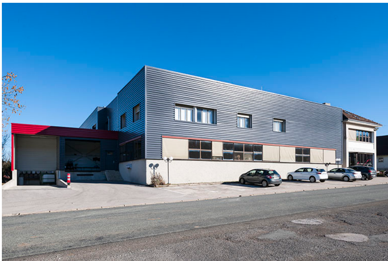
Façade antérieure : ateliers ouest.
