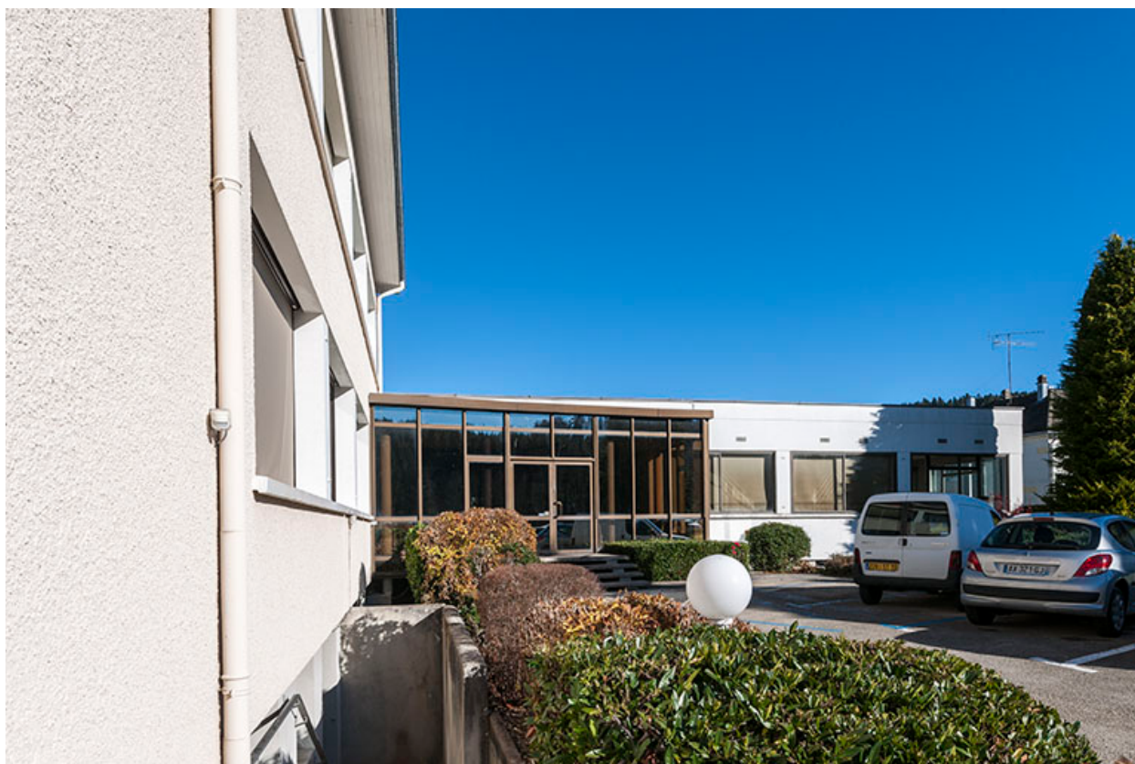
Façade antérieure : corps en retrait, à l'est.
