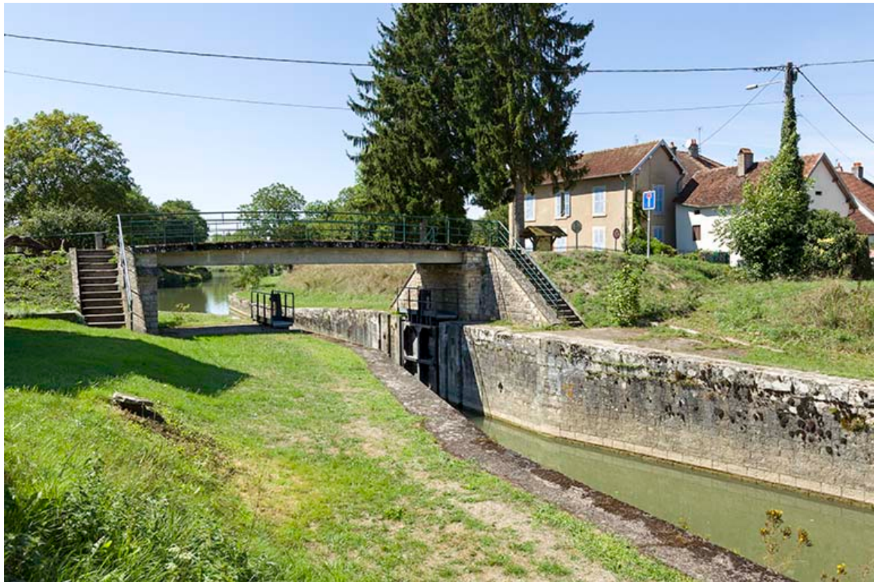
Vue amont de la porte de garde.
