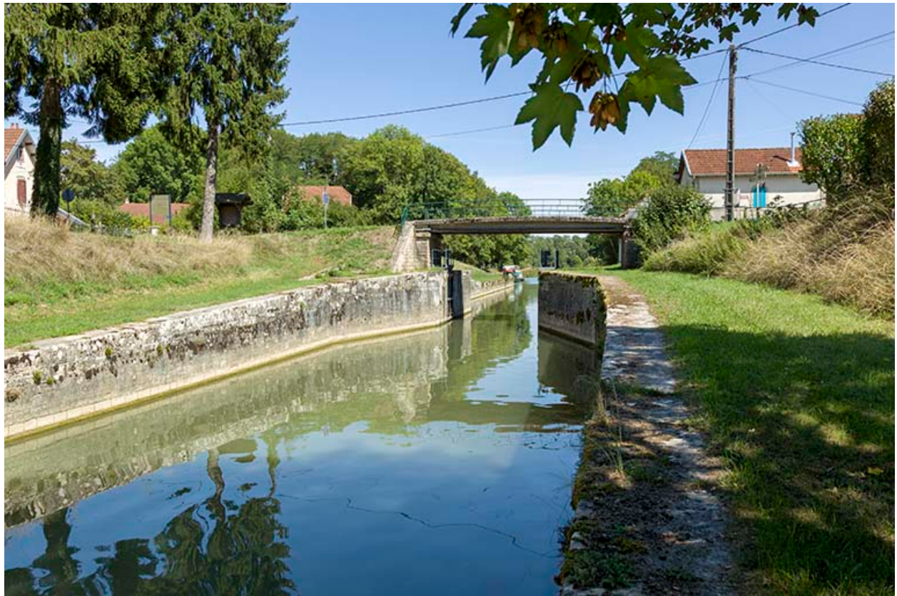
Vue depuis l'aval.
