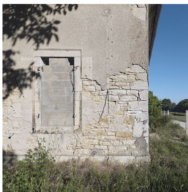
Détail du parement en moellon du mur et des chaînages de pierre de la fenêtre et des angles. Remarquez également le soubassement en pierre. Phot. Thierry Kuntz IVR26_20112102994NUC2A
