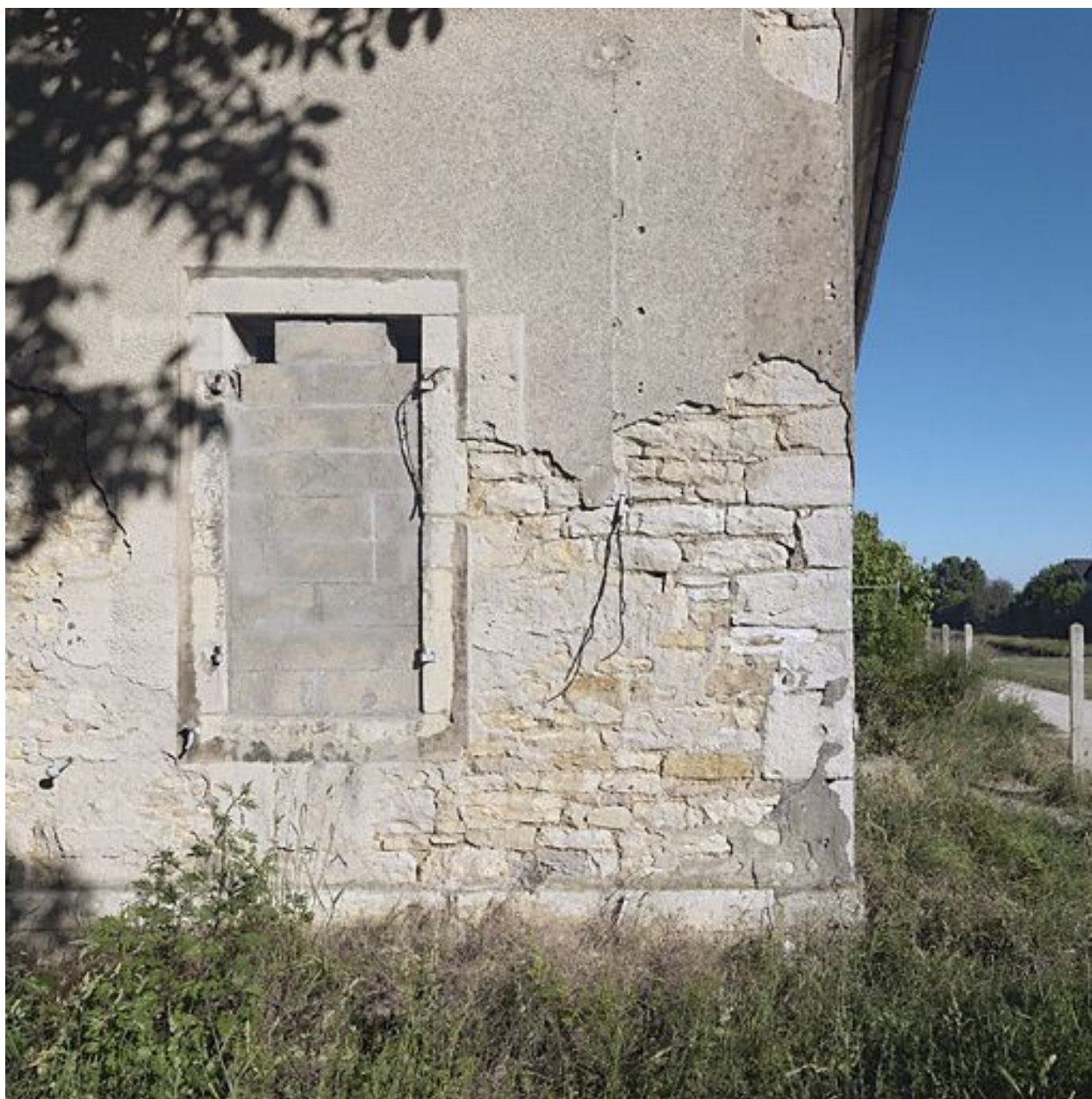
Détail du parement en moellon du mur et des chaînages de pierre de la fenêtre et des angles. Remarquez également le soubassement en pierre.
