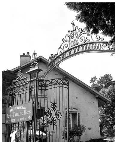
Détail de la grille d'entrée du parc. Phot. Yves Sancey IVR43_20029000400X
