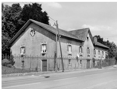
Vue de trois quarts de la conciergerie. Phot. Yves Sancey IVR43_20029000398X
