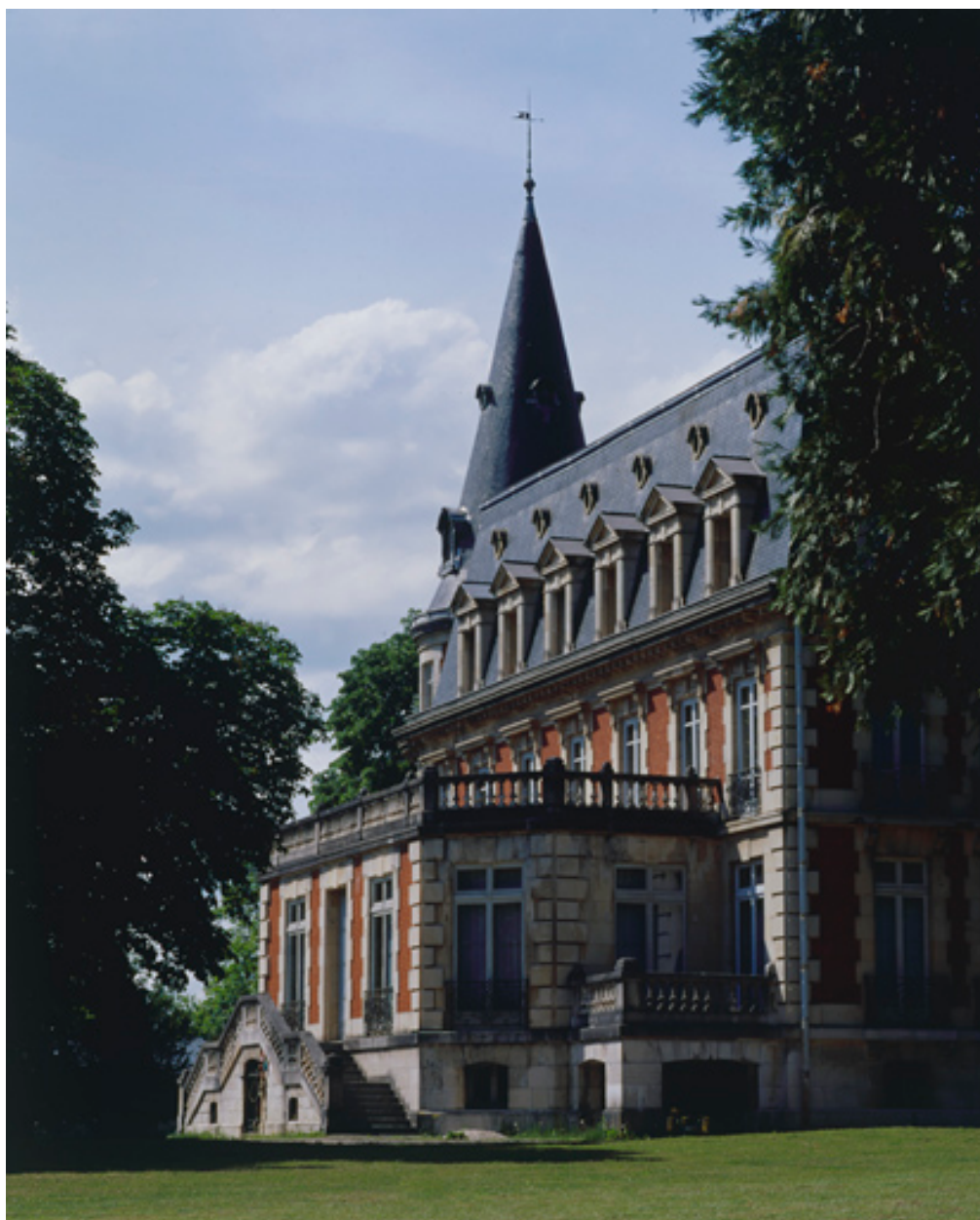
Façade sud vue de trois quarts.
