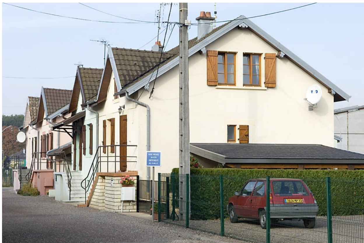
Logements doubles. Vue en enfilade depuis l'est.
