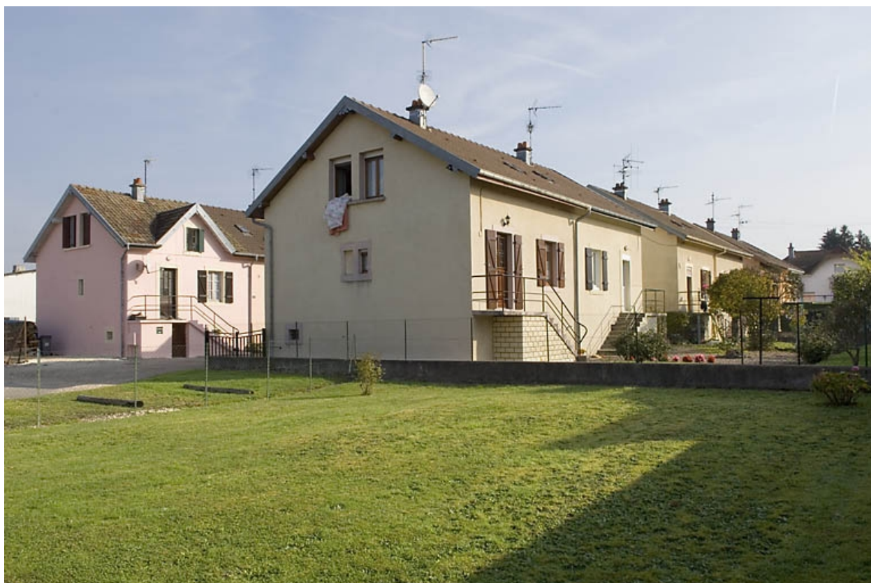
Ensemble de logements doubles.
