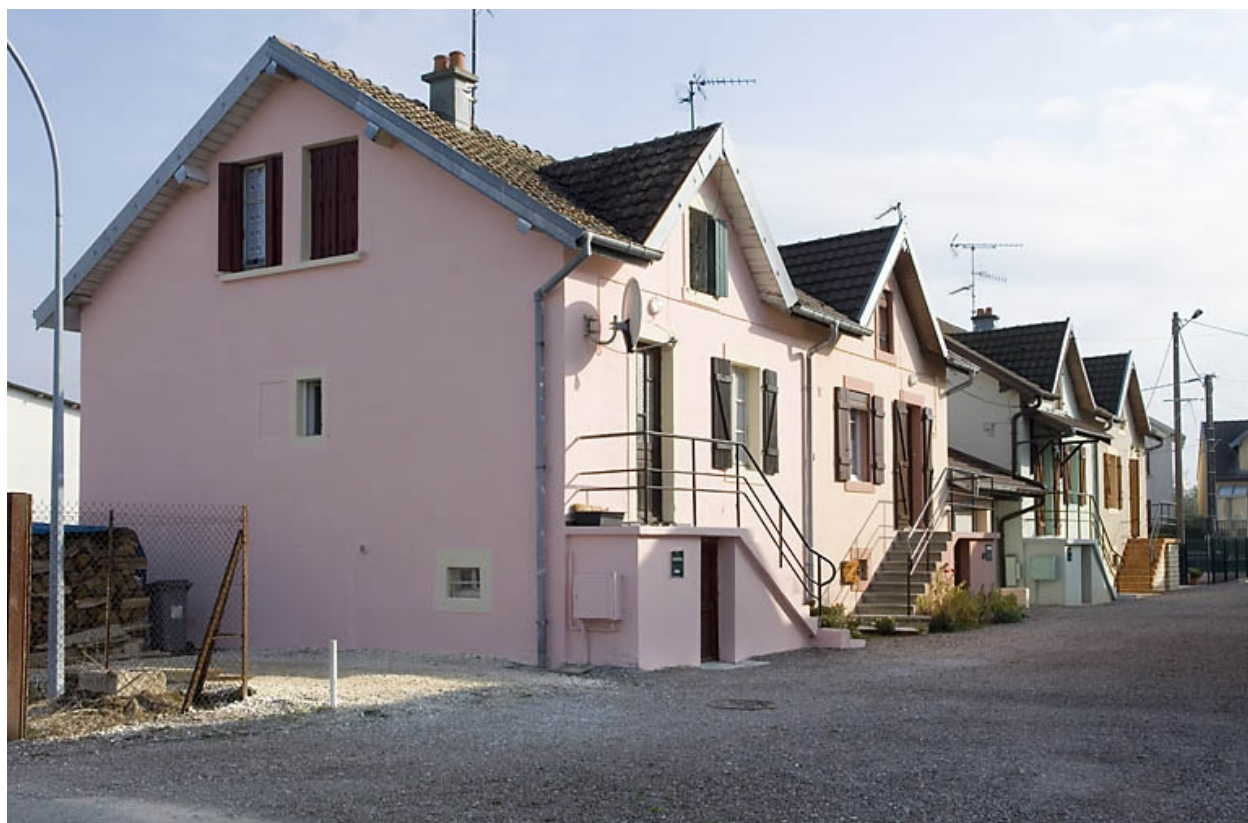
Logements doubles. Vue en enfilade depuis l'ouest.
