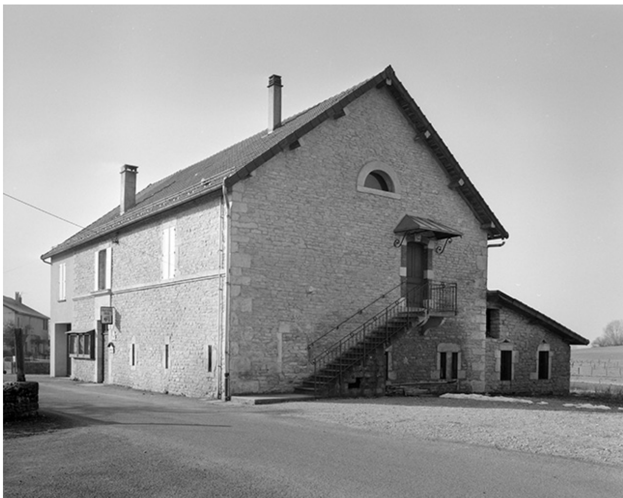
Vue depuis le nord.
