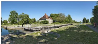
Site vu d'amont. Phot. Thierry Kuntz IVR26_20112103029NUC4A
