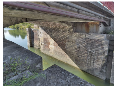
Le pont sur écluse : détail des maçonneries du dessous du tablier.
