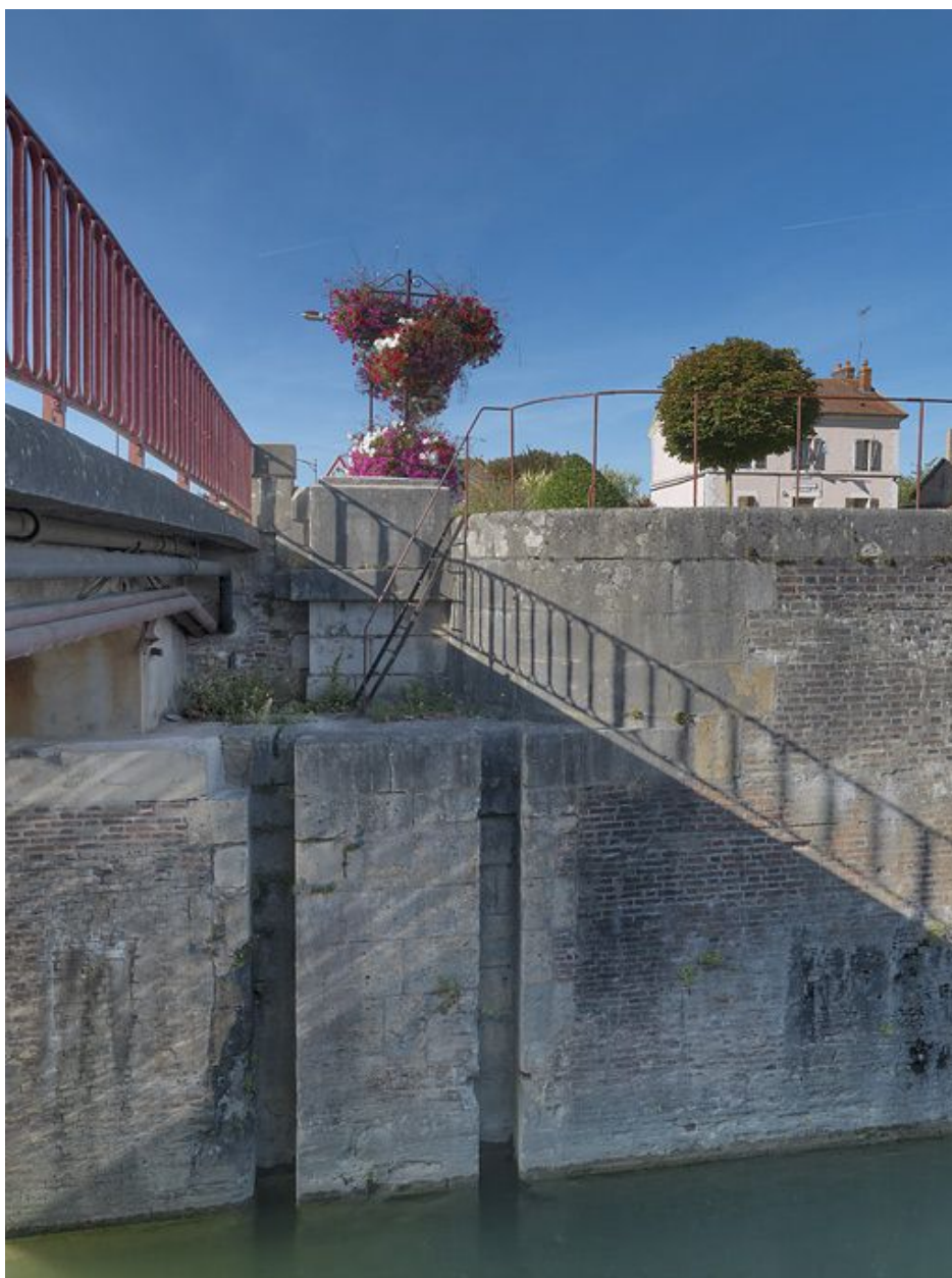
Le pont sur écluse : détail des maçonneries.
