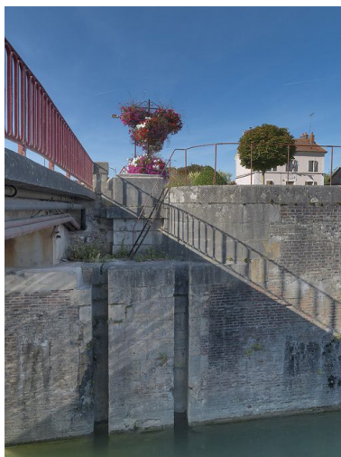
Le pont sur écluse : détail des maçonneries.
