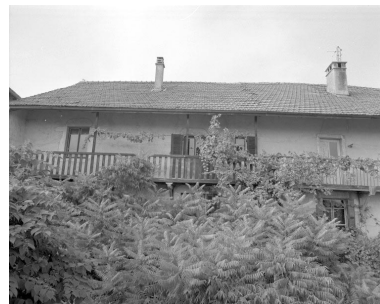
Façade antérieure, balcon. Phot. Jérôme Mongreville IVR43_19943901145X
