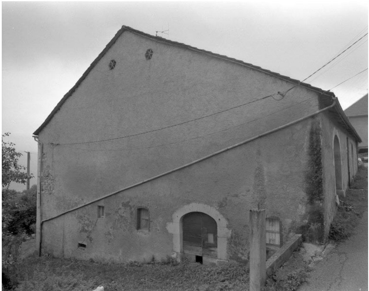
Face droite avec accès à l'étable.
