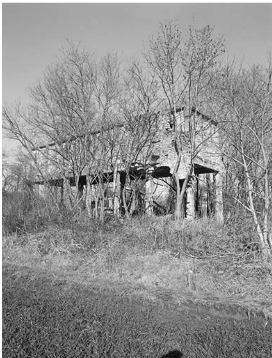
Réservoir industriel (bac à saumure).
