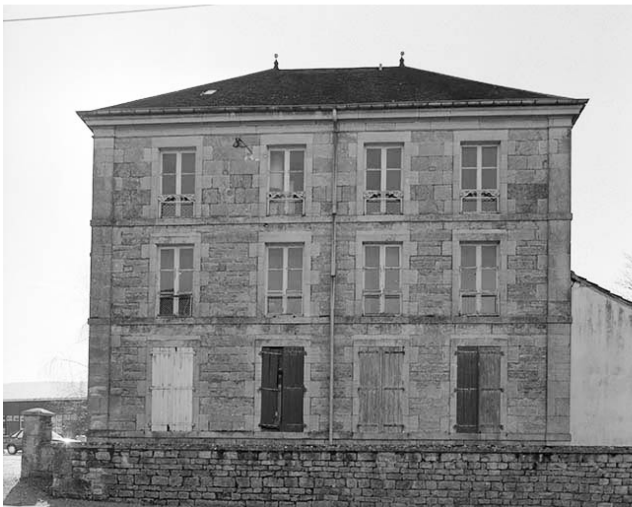
Façade antérieure du logement d'ouvriers.
