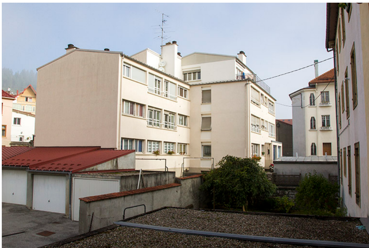
Bâtiment sud : vue d'ensemble, depuis le sud.
