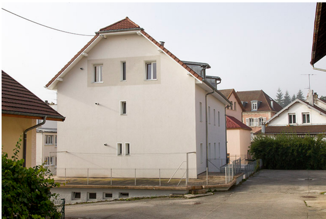
Bâtiment nord : façades latérale droite et postérieure.
