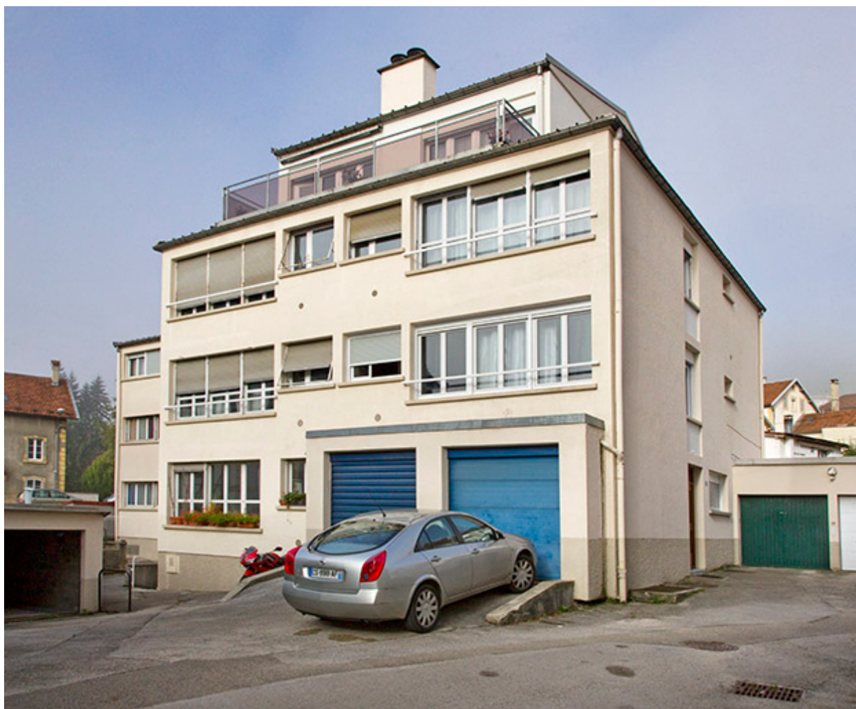
Bâtiment sud : façades antérieure et latérale droite.
