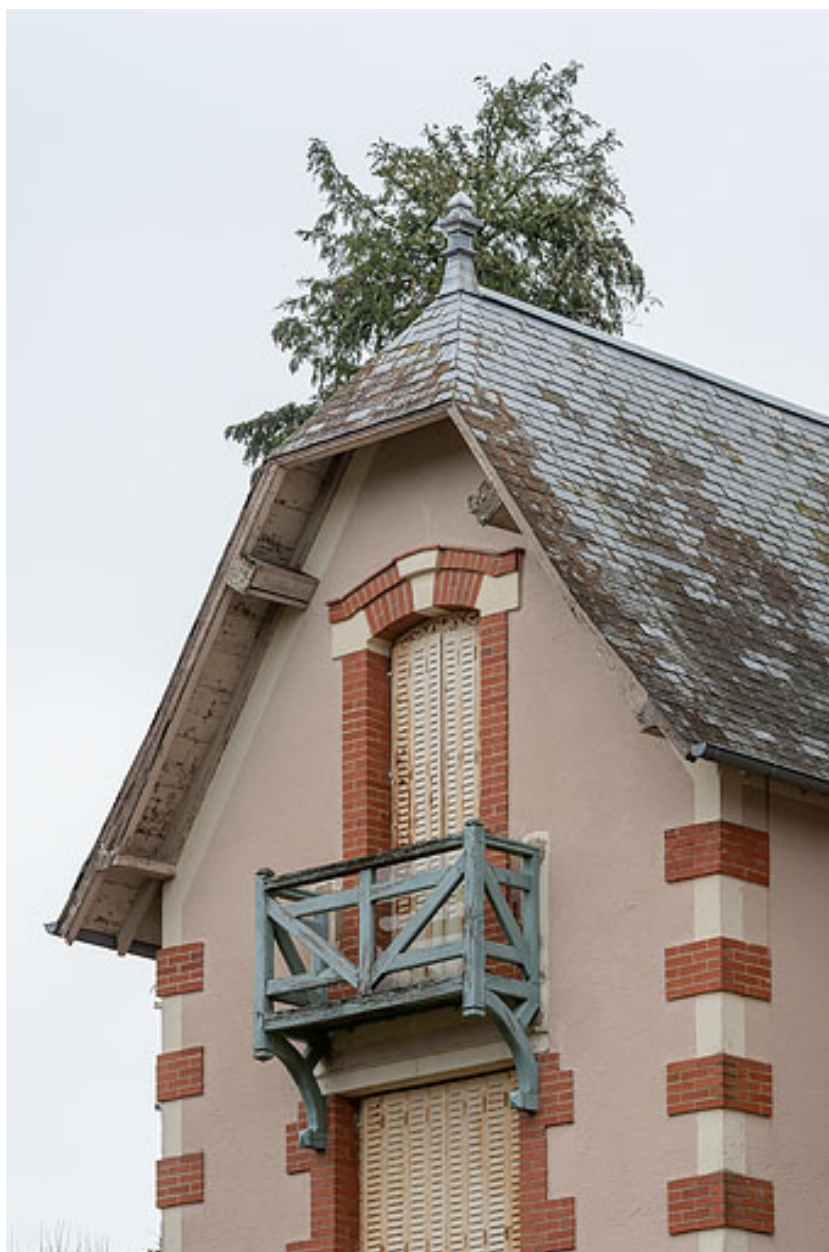
Mur-pignon en façade, demi-croupe en ardoise.
