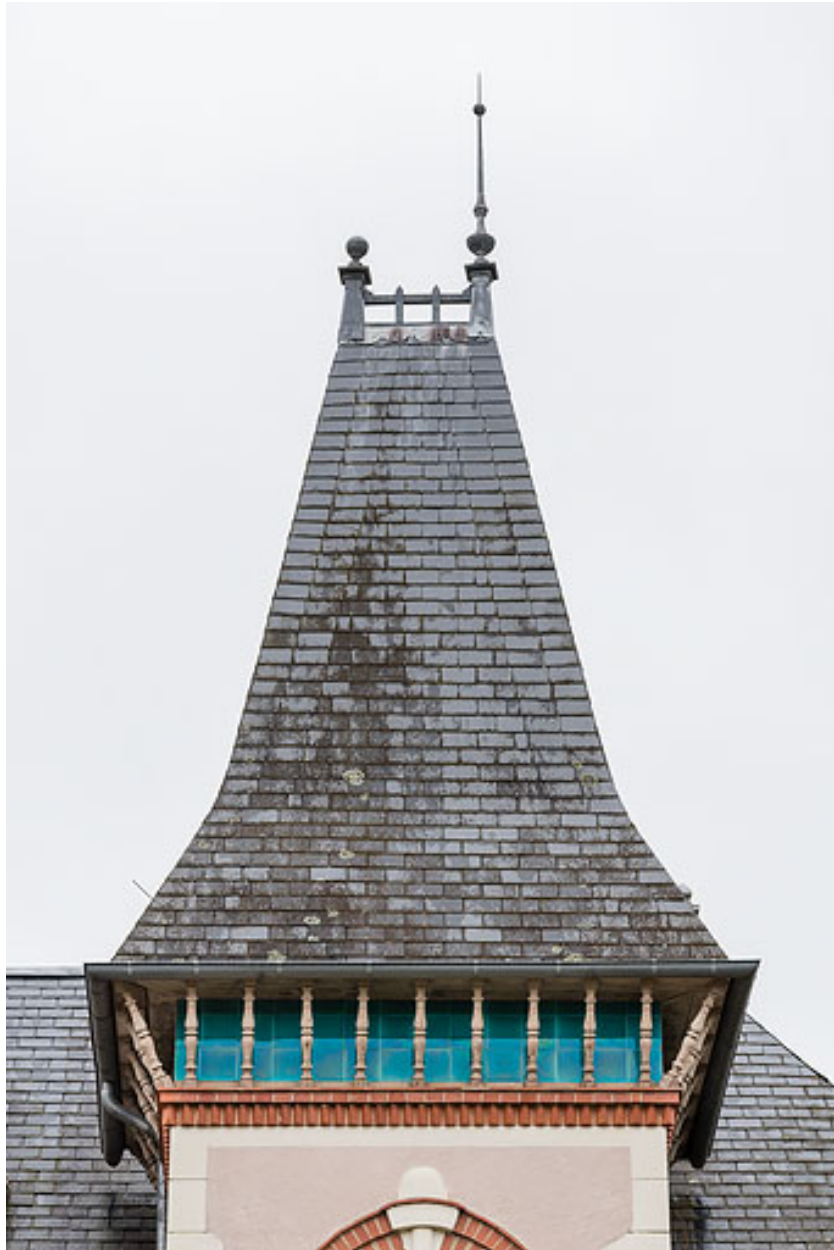
Tour demi-hors-œuvre, toiture et crête faîtière.
