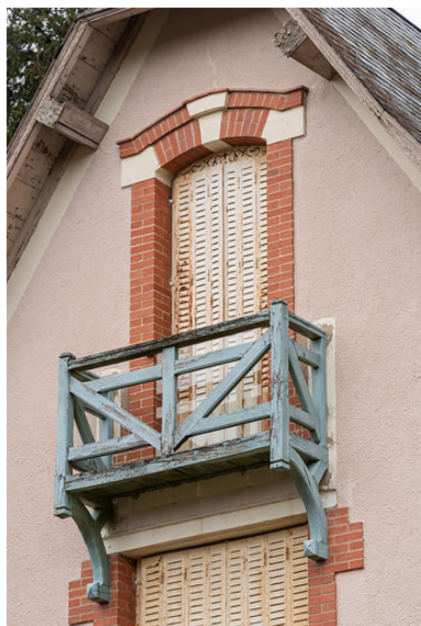
Mur-pignon en façade, garde- corps en bois du balcon. Phot. Pierre-Marie Barbe-Richaud IVR26_20205800257NUC4A
