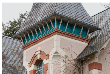
Tour demi-hors-œuvre, décor de céramique. Phot. Pierre-Marie Barbe-Richaud IVR26_20205800258NUC4A
