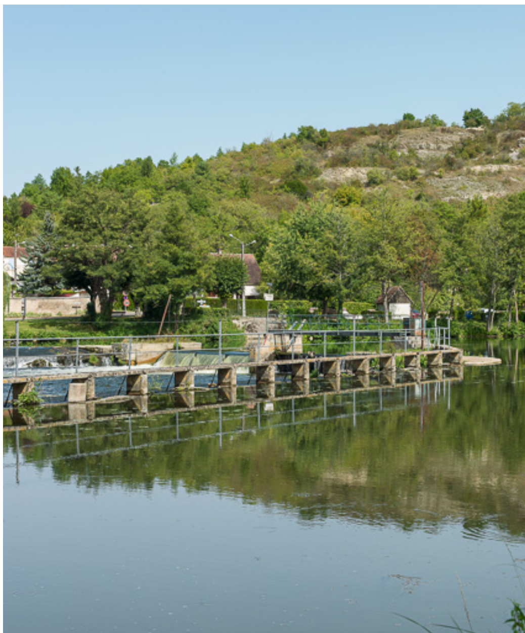
Vue du barrage.
