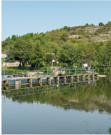
Vue du barrage.
