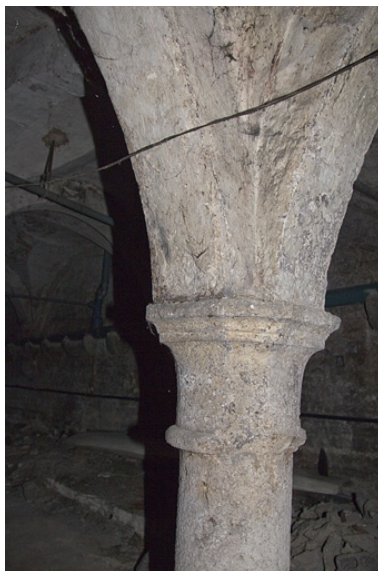
Logis principal : détail du chapiteau d'une colonne soutenant les voûtes de la cave.
