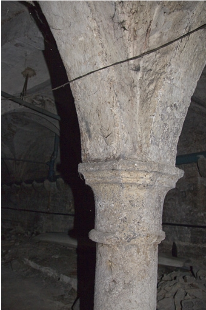
Logis principal : détail du chapiteau d'une colonne soutenant les voûtes de de la cave.
