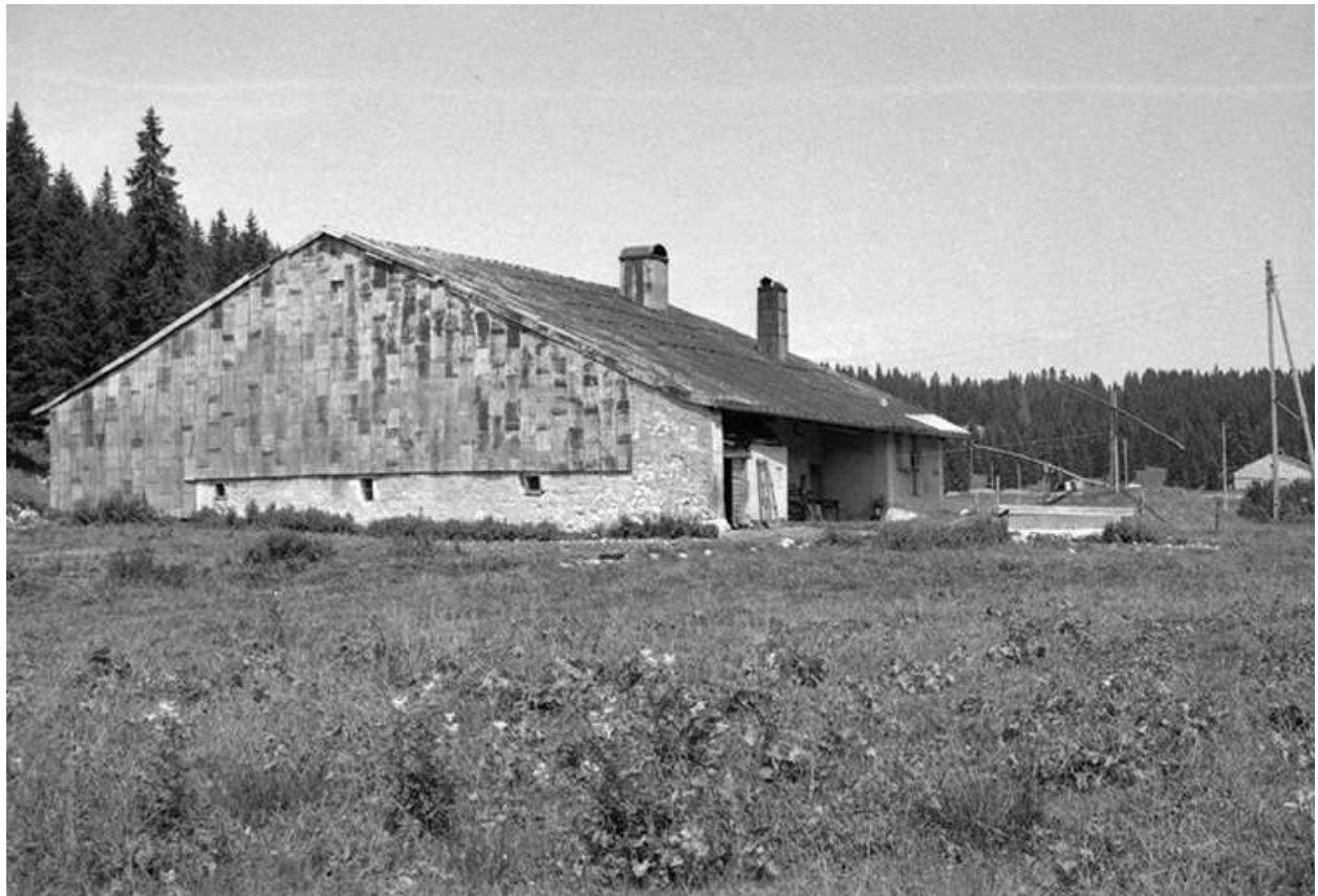
Façades antérieure et latérale gauche.
