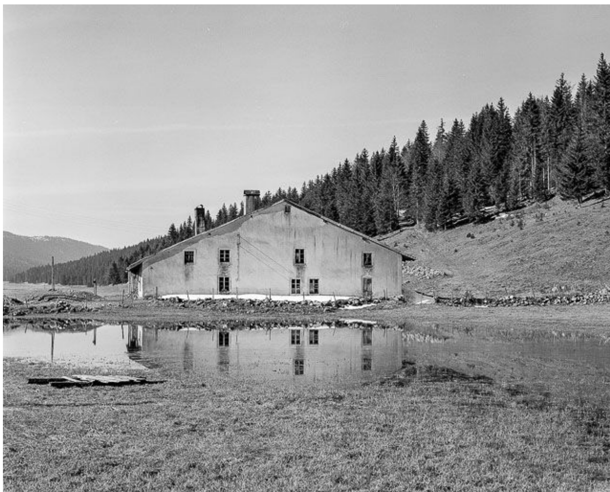
Façade latérale droite.
