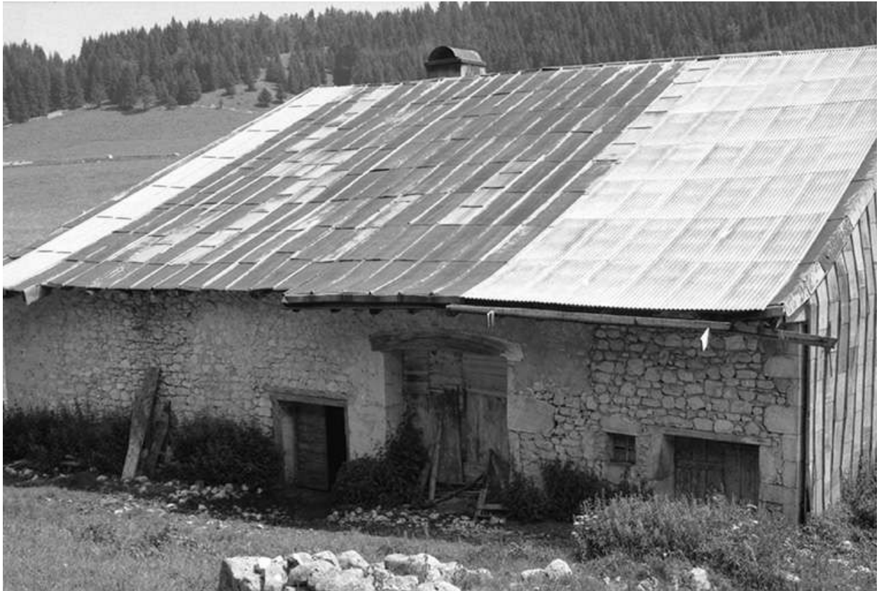
Façade postérieure, porte de grange, écuries.
