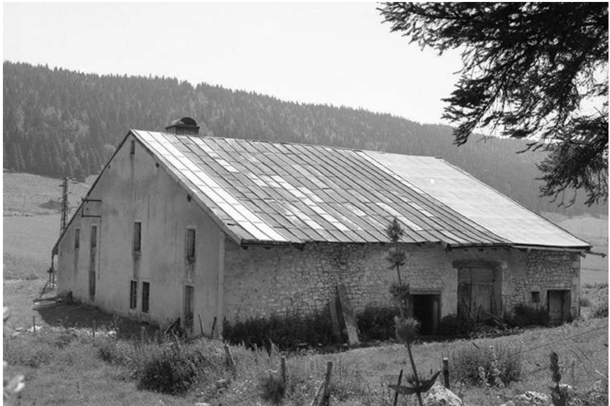
Façades postérieure et latérale droite.
