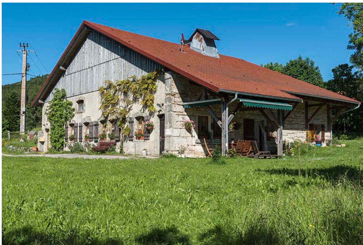
Façades antérieure et latérale droite.
