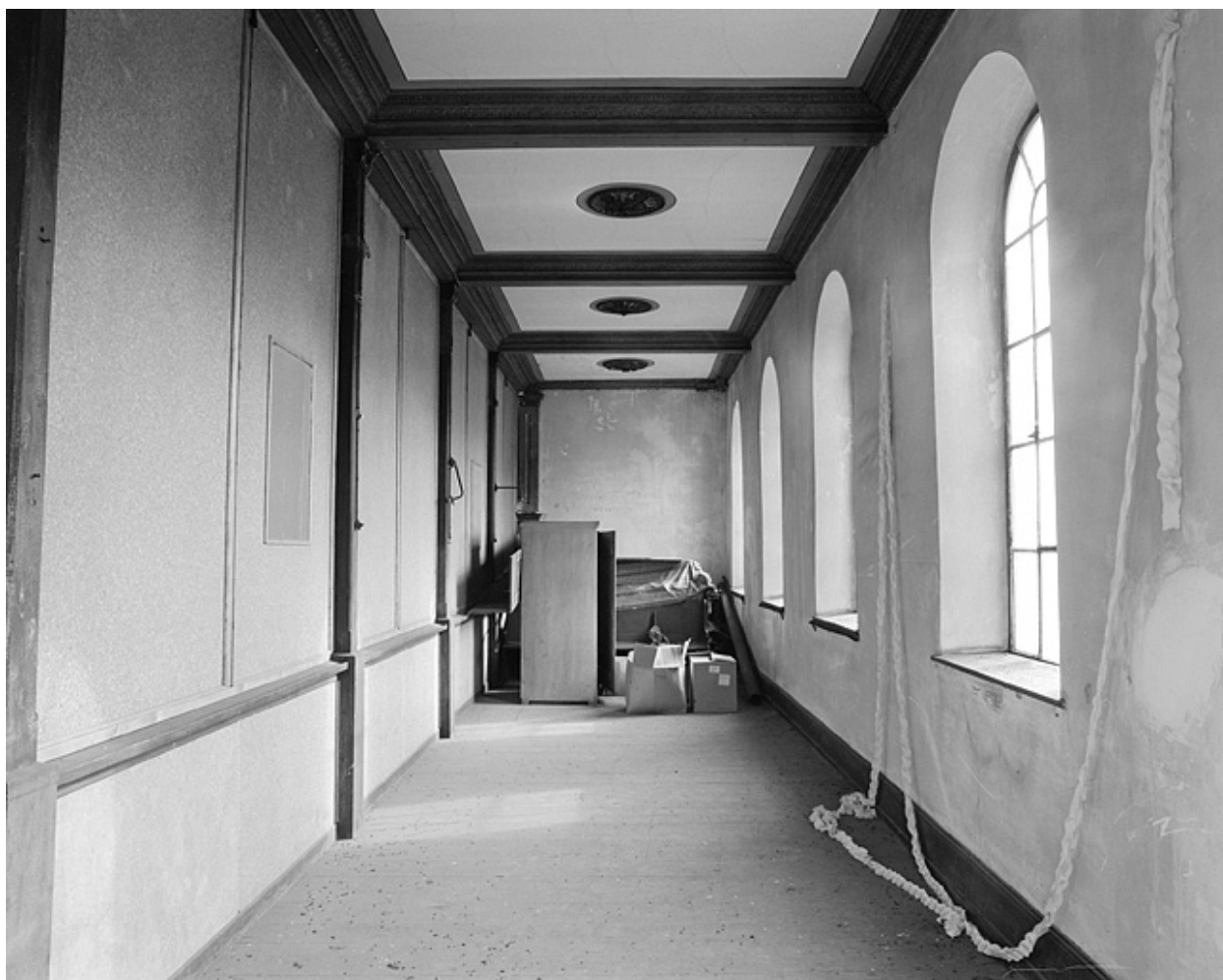
Vue intérieure de la tribune sud.
