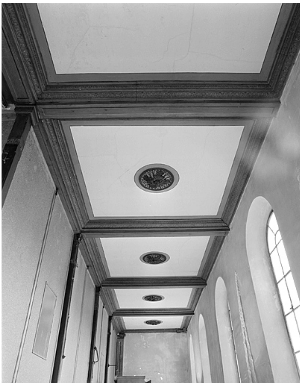
Plafond de la tribune sud.
