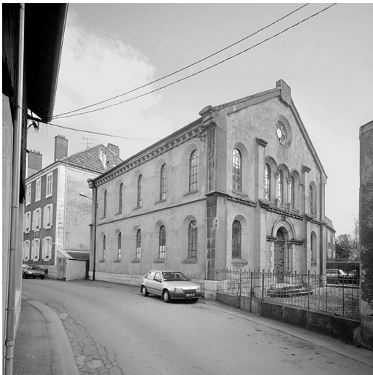
Vue d'ensemble côté rue de la Synagogue.
