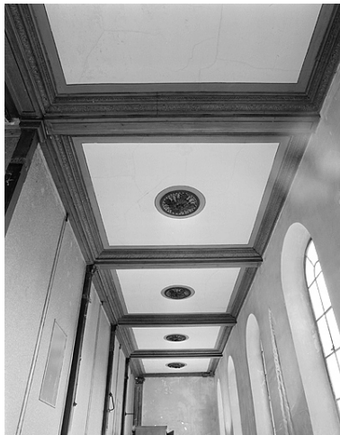
Plafond de la tribune sud.
