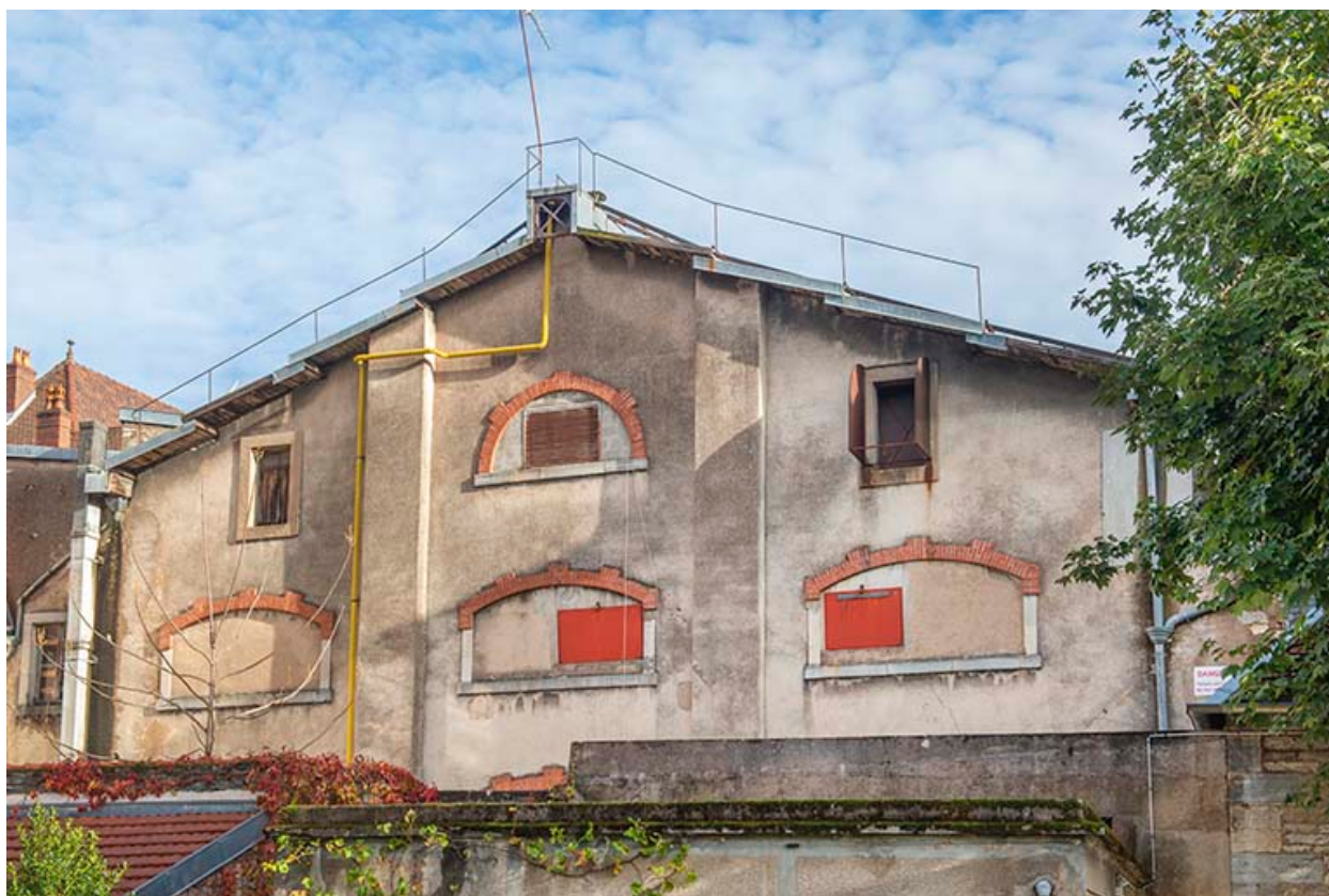
Façade postérieure de la halle (partie haute).
