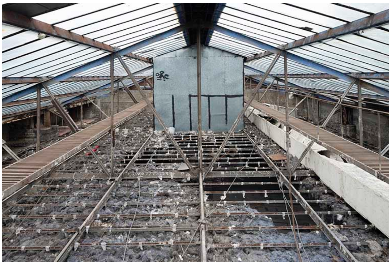
Halle : charpente métallique et verrière.
