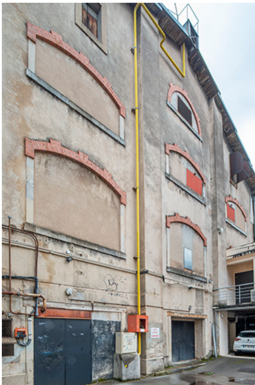
Halle : façade postérieure depuis la cour.
