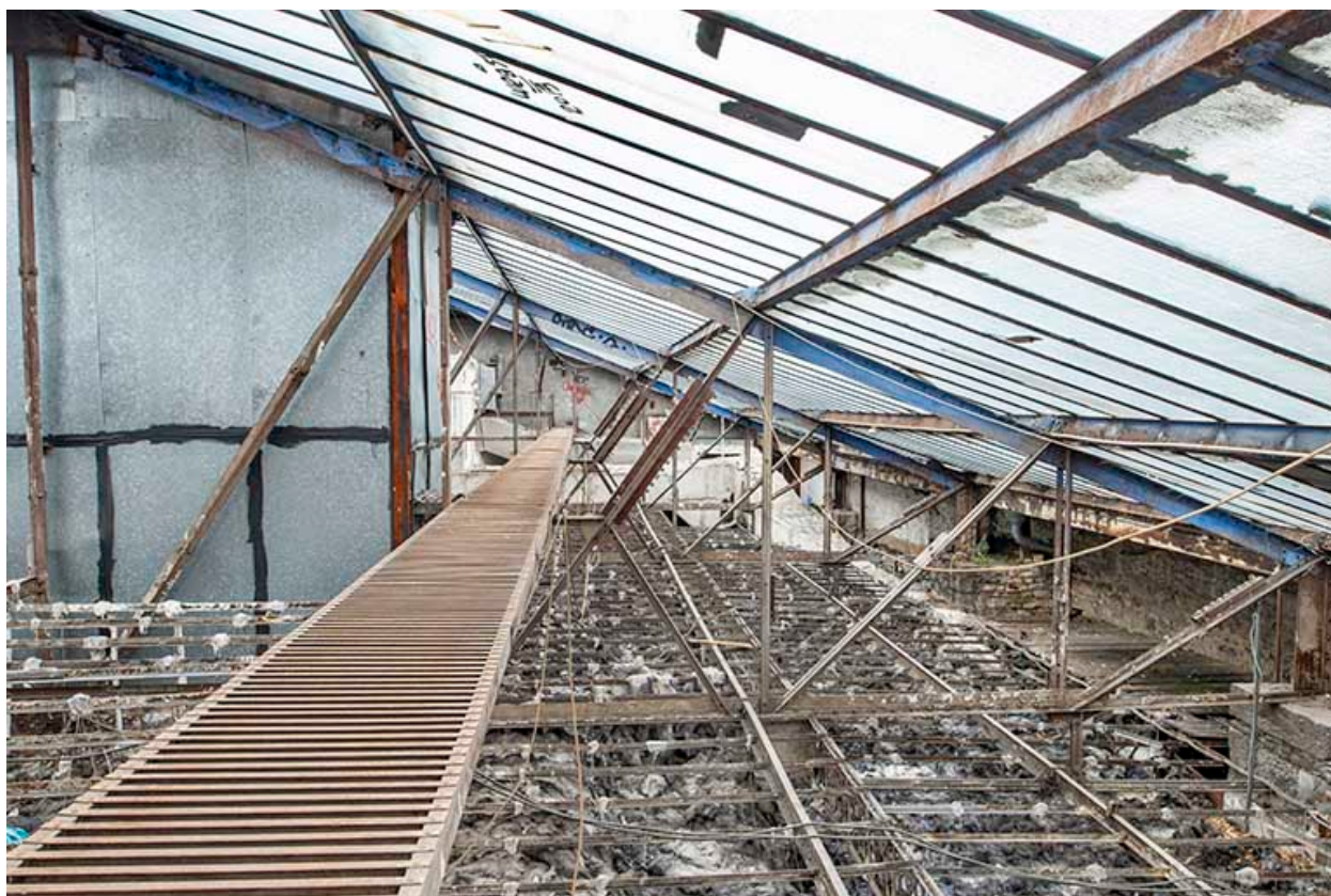
Halle : charpente métallique et passerelle.
