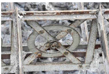
Halle : décor de la charpente métallique.
