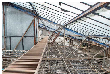
Halle : charpente métallique et passerelle.
