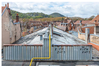
Halle : verrière. Phot. Jérôme Mongreville IVR43_20232500079NUC4A
