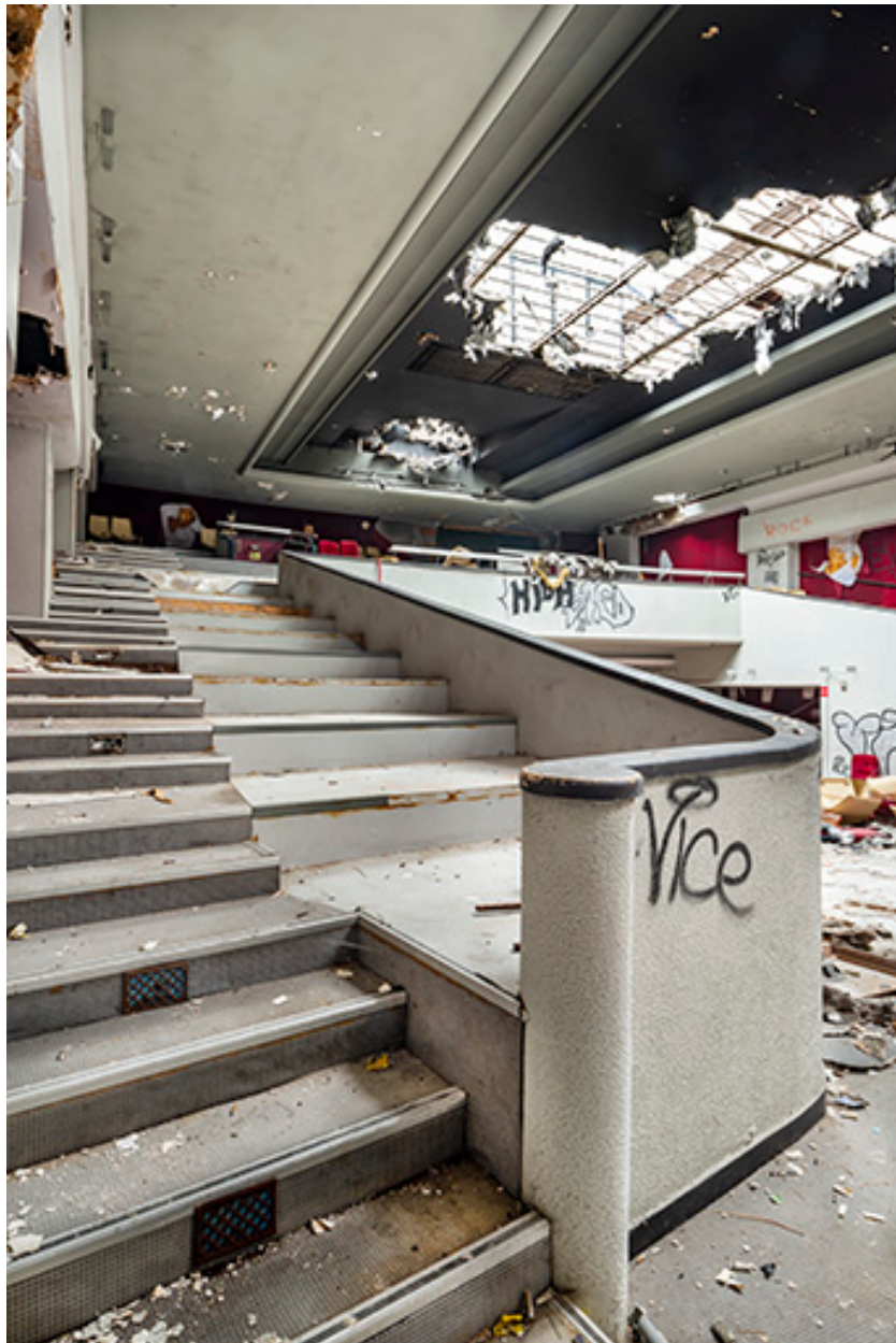
Halle : grande salle, accès au balcon.
