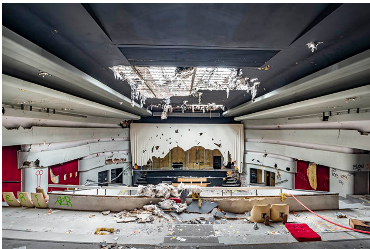
Halle : grande salle, vue depuis le balcon.
