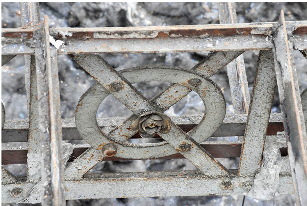
Halle : décor de la charpente métallique.
