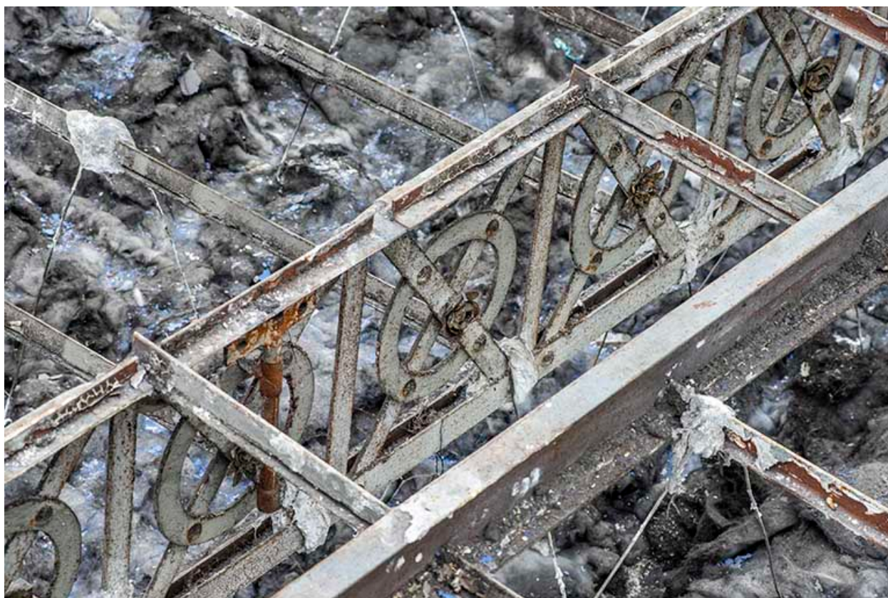
Halle : détail de la charpente métallique.
