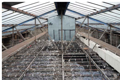
Halle : charpente métallique et verrière.
