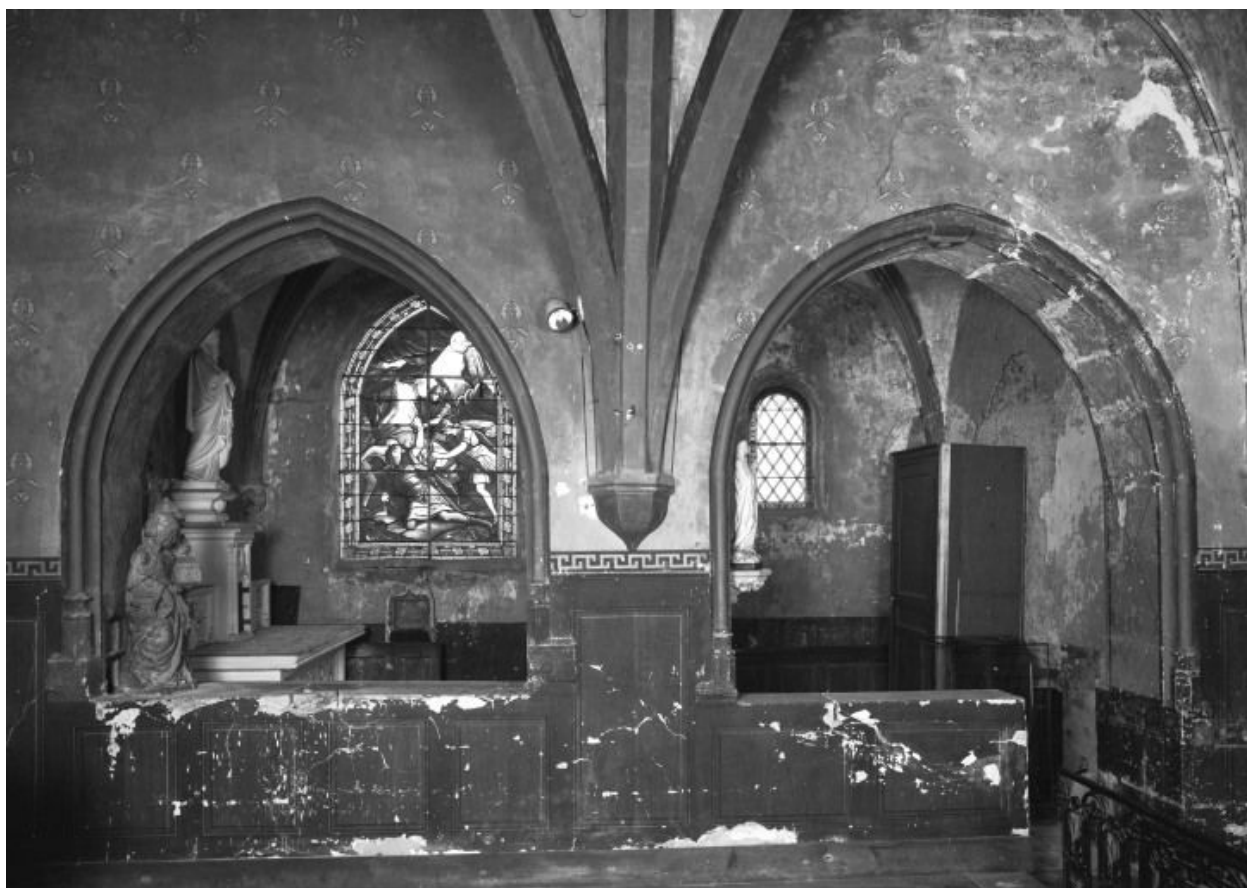
Chapelle latérale, vue depuis le chœur
