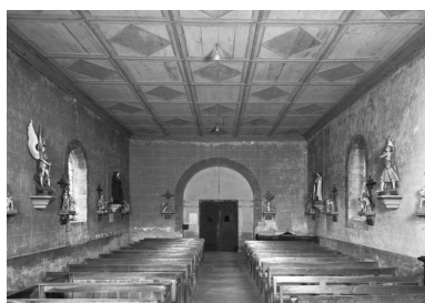
Vue intérieure prise du chœur Phot. Jean-Luc Duthu IVR26_19862101217V
