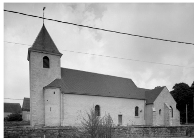
Elévation droite Phot. Michel Thierry IVR26_19862101208V
