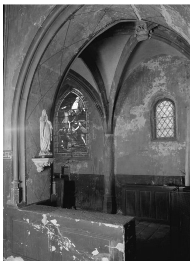
Chapelle latérale, première travée Phot. Jean-Luc Duthu IVR26_19862101220V
