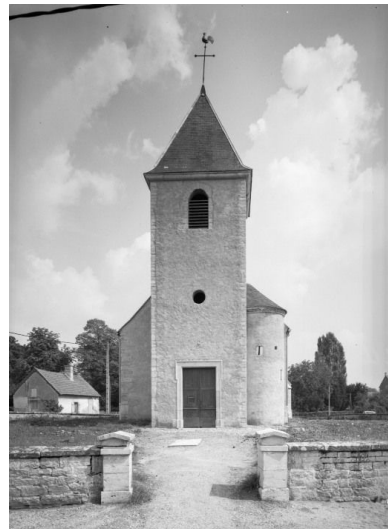
Elévation antérieure Phot. Michel Thierry IVR26_19862101206V
