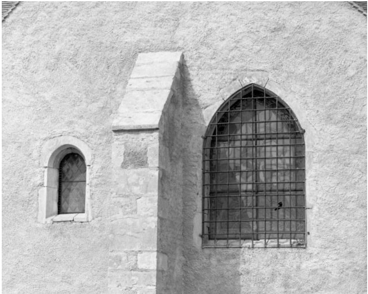
Chapelle latérale droite, baies
