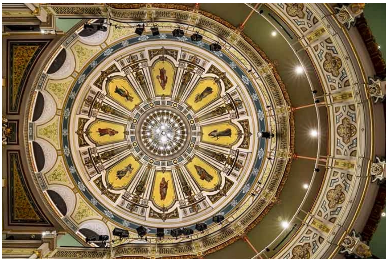
Vue d'ensemble du plafond.
