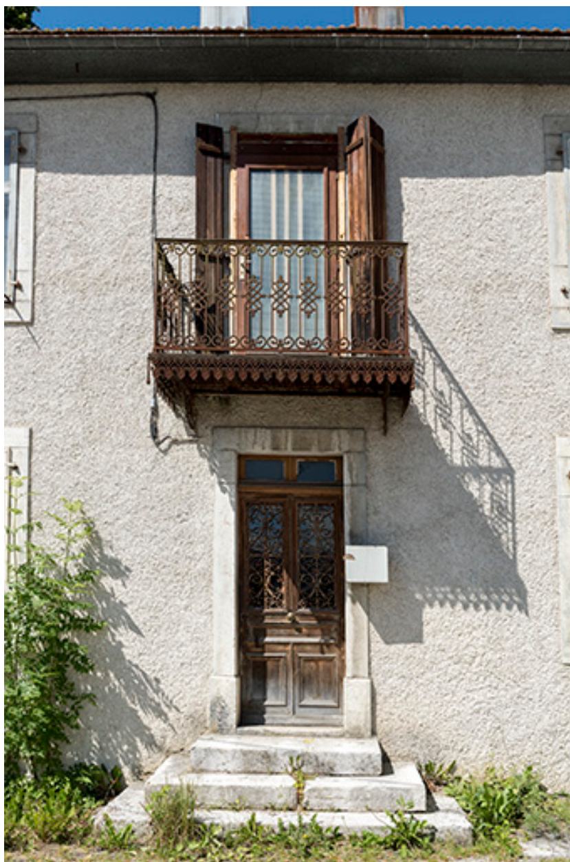
Façade antérieure : travée centrale.
