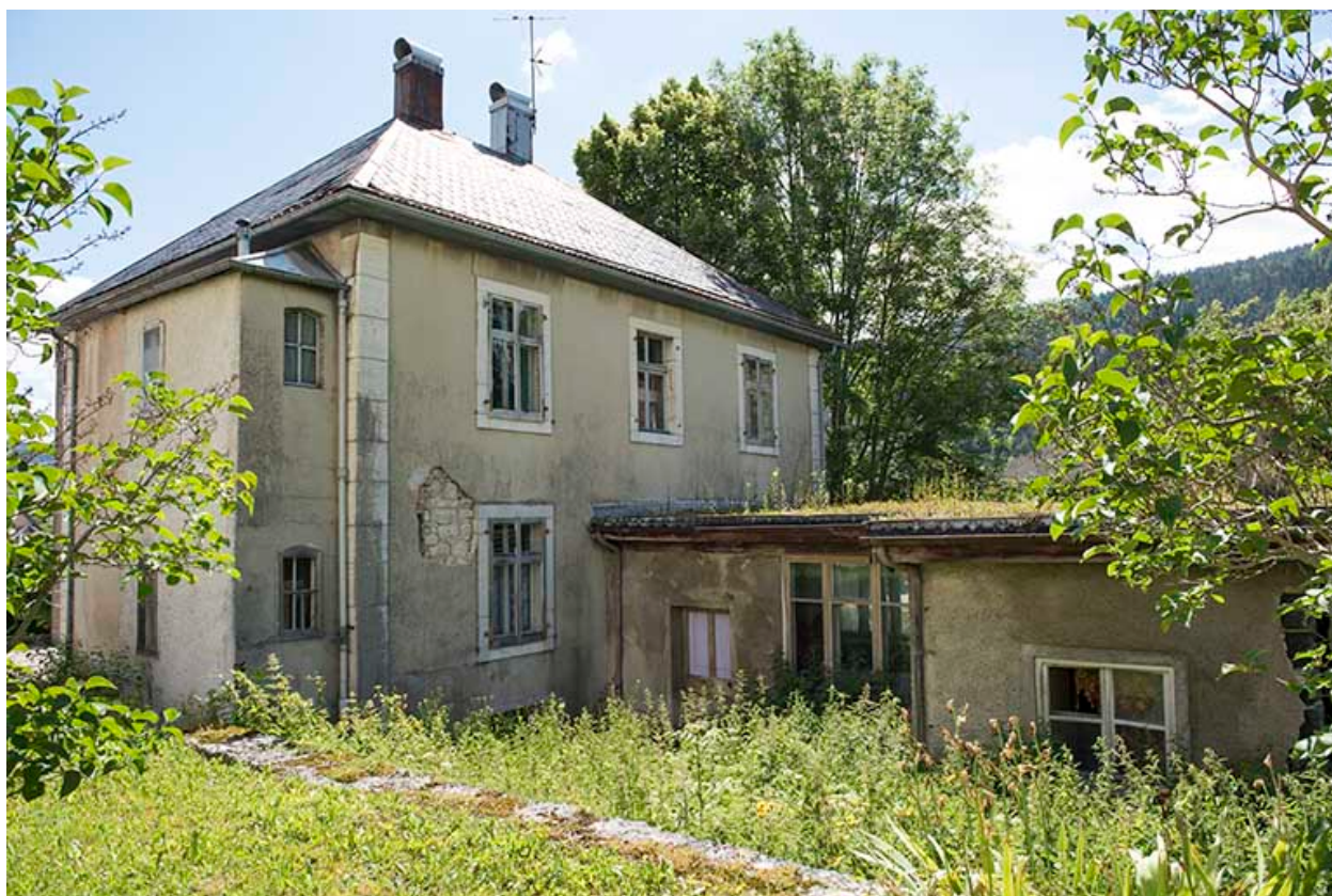
Façade postérieure et atelier de fabrication.
