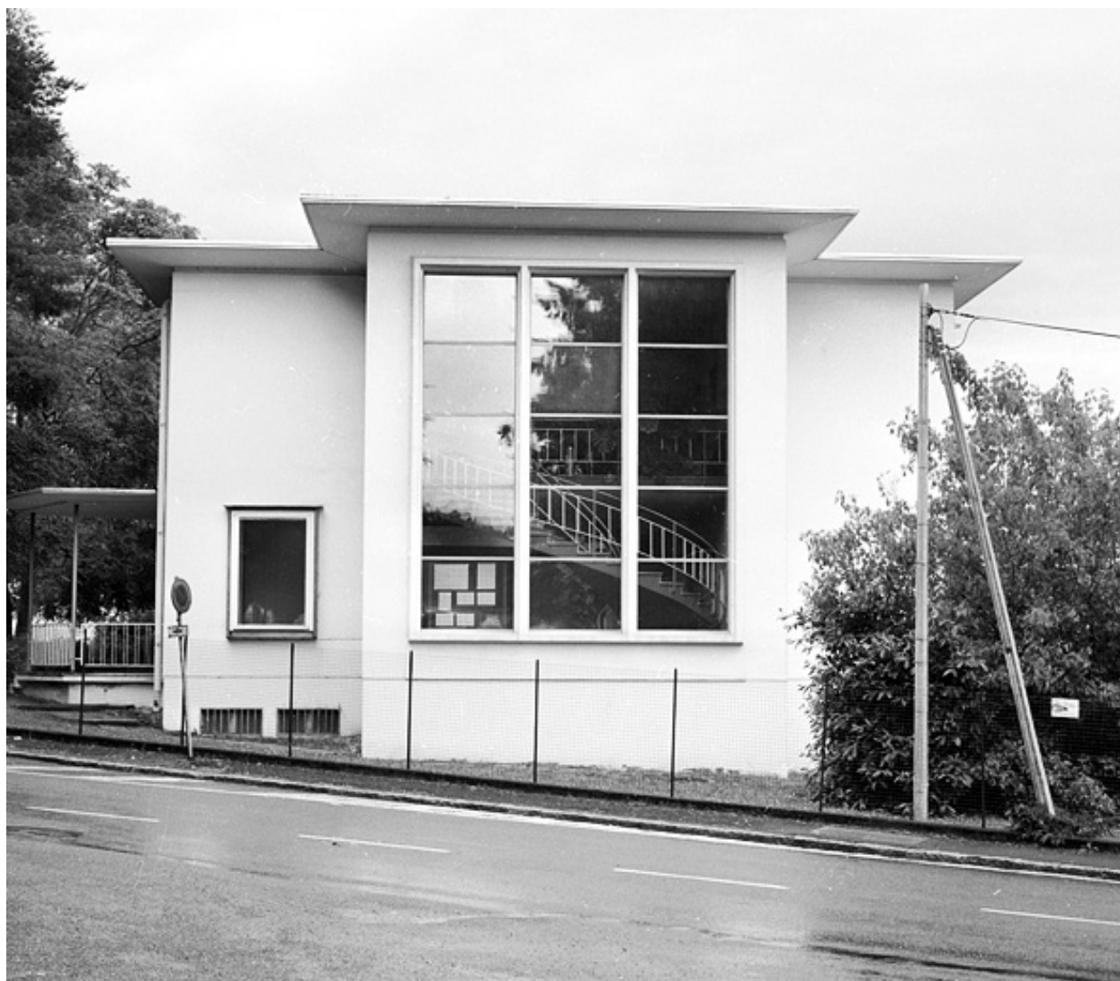
Façade nord du bâtiment administratif d'entreprise.
