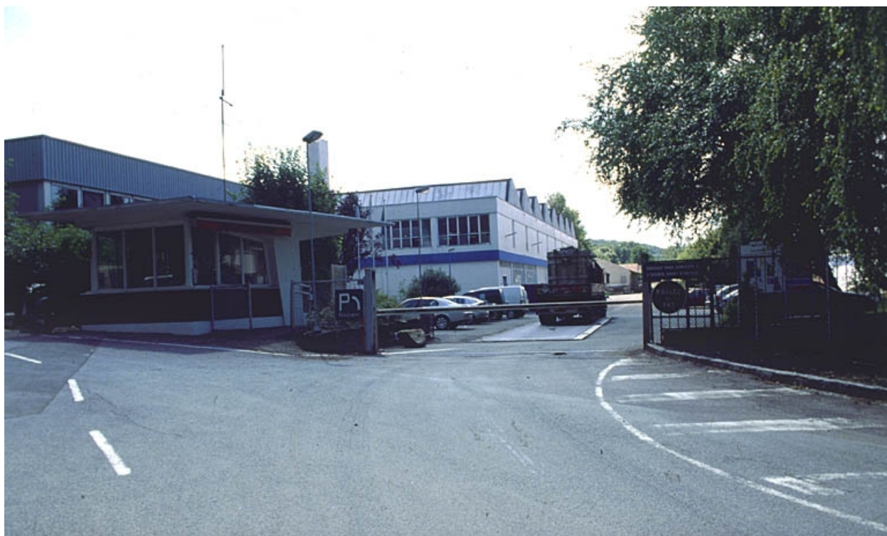
Entrée de l'usine.
