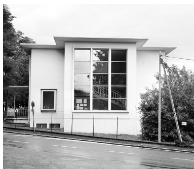
Façade nord du bâtiment administratif d'entreprise.
