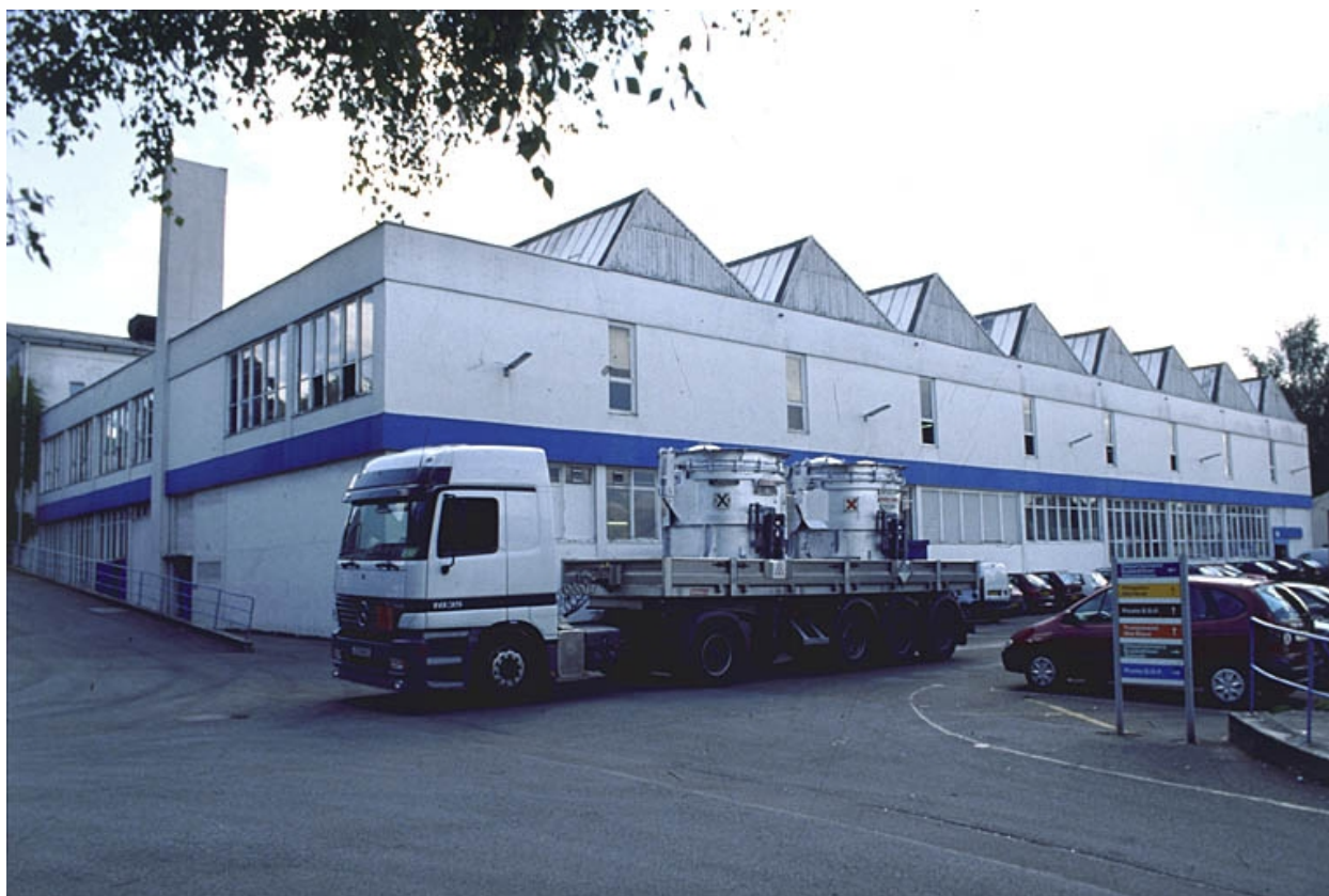
Atelier de fabrication des pièces en aluminium.
