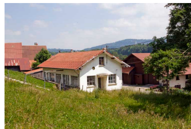
Atelier d'origine : façades postérieure et latérale gauche. Phot. Yves Sancey IVR43_20132501259NUC2A
