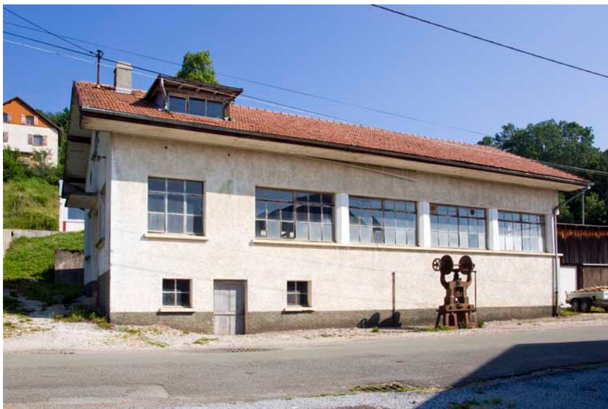
Atelier d'origine : façade antérieure.
