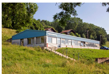
Atelier récent. Phot. Yves Sancey IVR43_20132501257NUC2A
