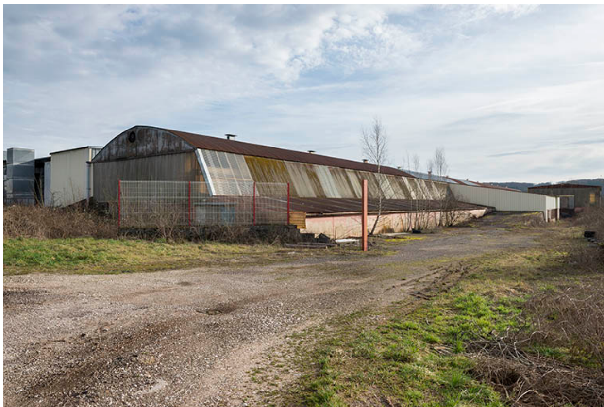
L'atelier de fabrication des panneaux.
