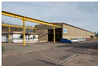
L'atelier de fabrication des moules métalliques. Phot. Jérôme Mongreville IVR43_20187000019NUC4A
