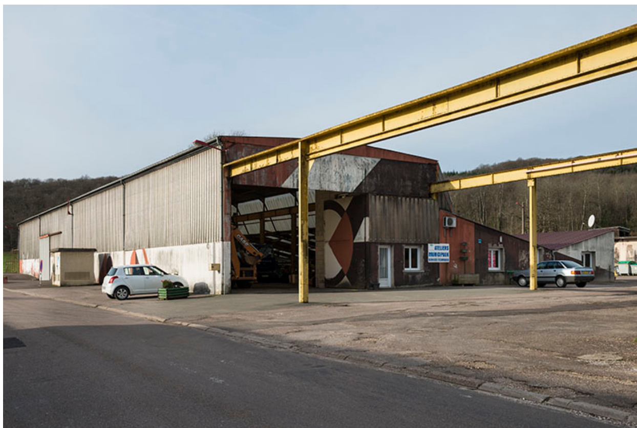
Le bâtiment d'entretien des véhicules.
