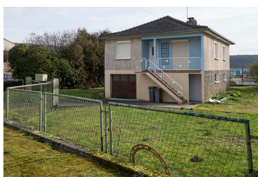
La maison témoin. Phot. Jérôme Mongreville IVR43_20187000018NUC4A
