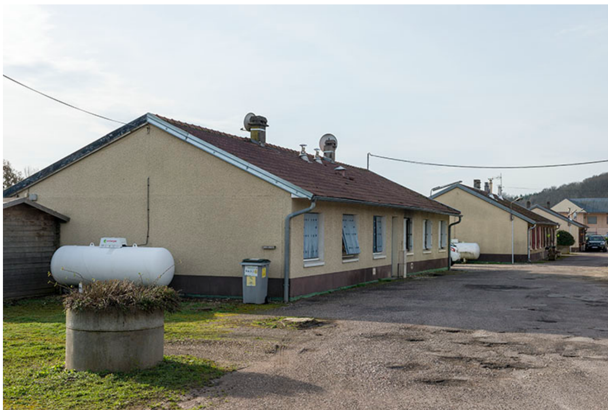
Bâtiment servant de cantine et logement.
