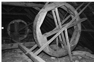
Combles : treuils autrefois utilisés pour descendre et monter les lustres ? Phot. Jérôme Mongreville IVR43_20003900753Z
