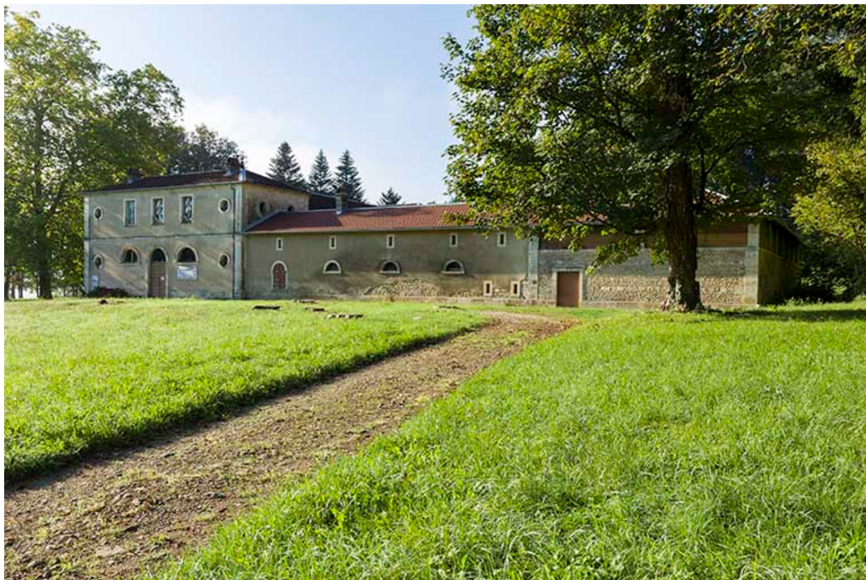
Façade latérale droite de la ferme.
