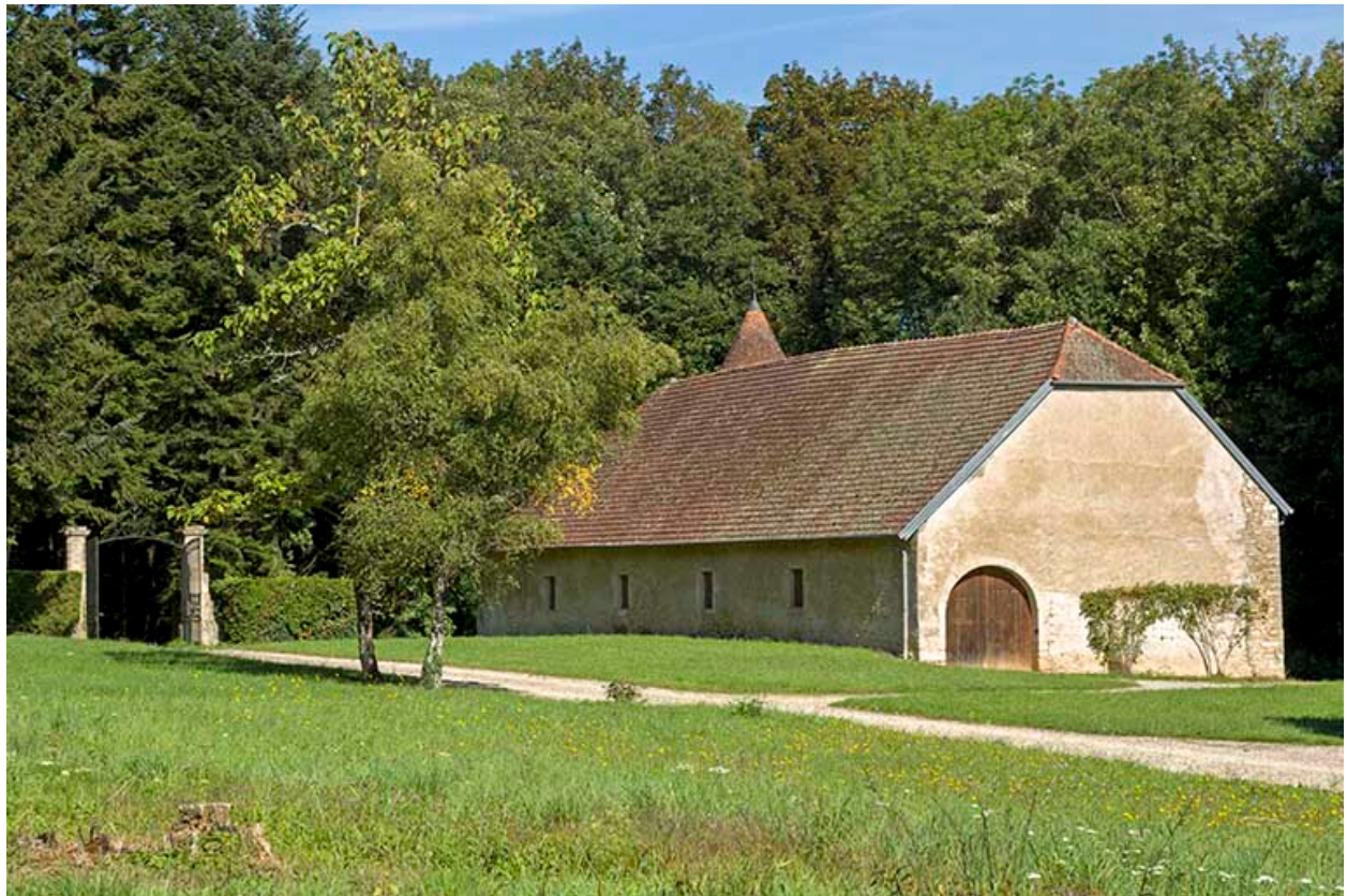
Vue générale du cuvage.
