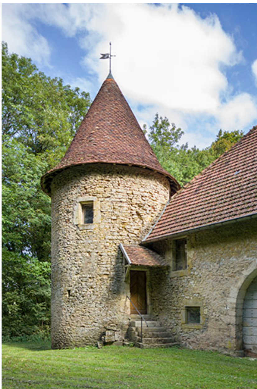
La tour à l'angle nord-est du cuveau.
