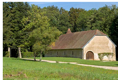
Vue générale du cuvette. Phot. Sonia Dourlot IVR43_20167000743NUC2A
