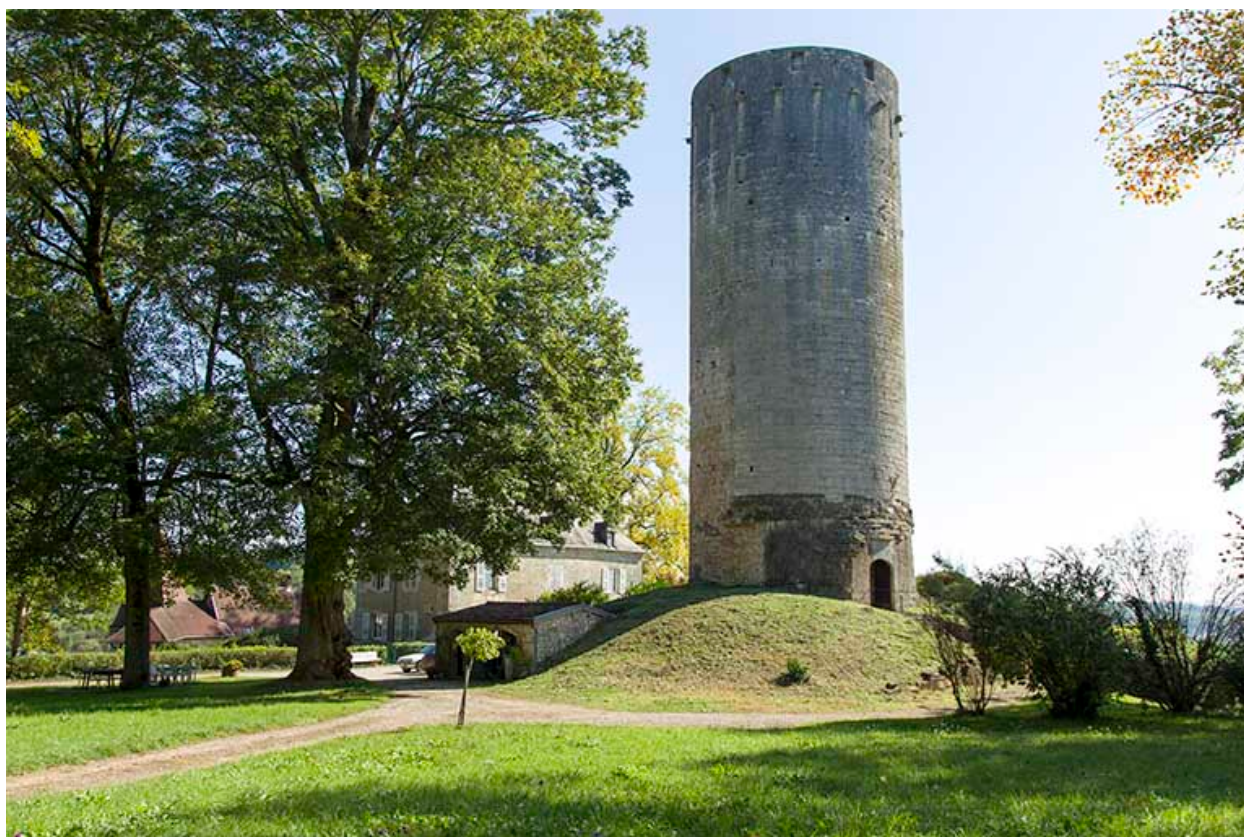
Vue générale du donjon depuis le parc.
