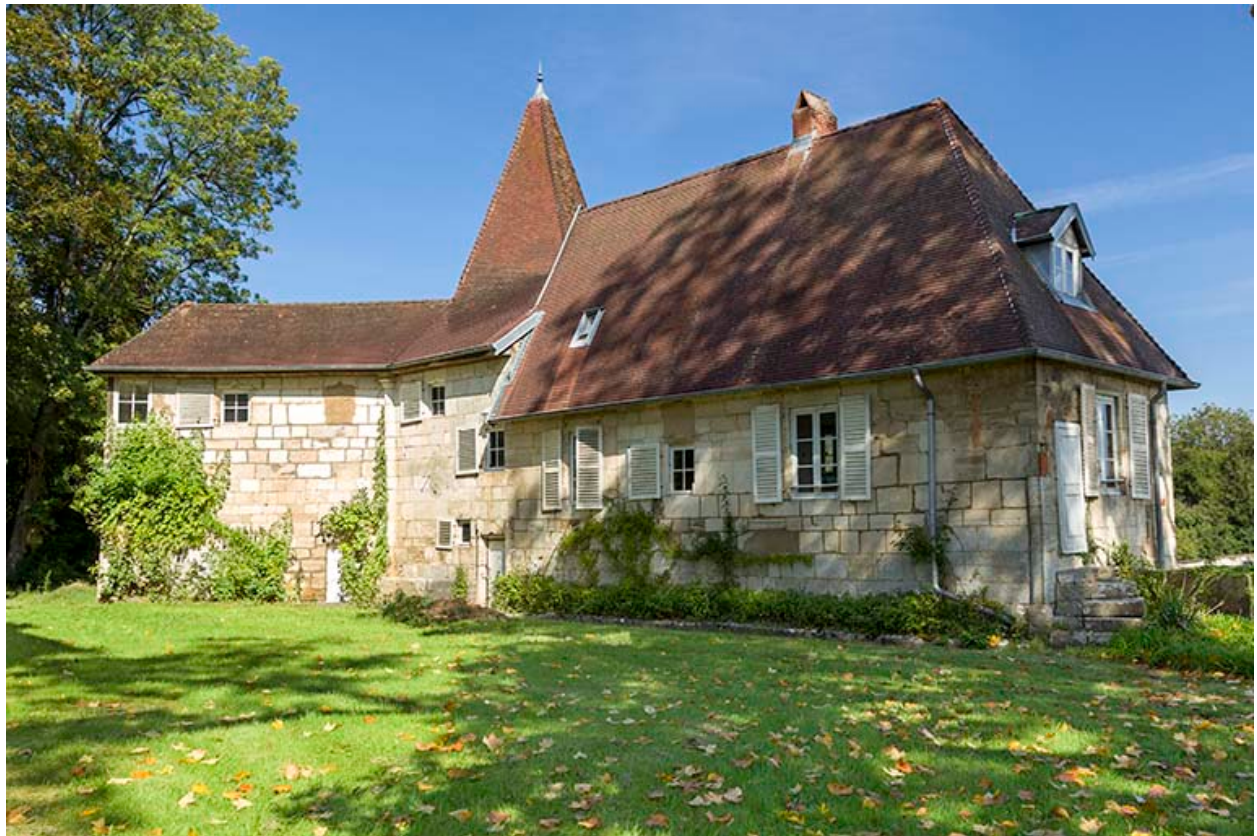
Façade antérieure du "vieux château".
