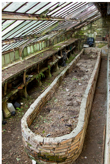
Intérieur de la serre accollée à la façade sud.
