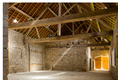
Intérieur du cuvette, en direction du sud-est. Phot. Sonia Dourlot IVR43_20167000746NUC2A
