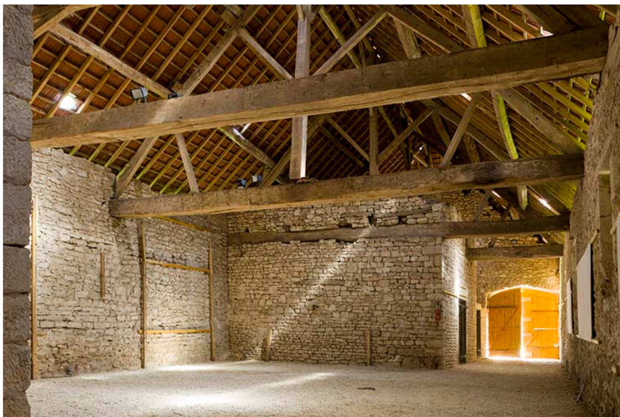
Intérieur du cuvage, en direction du sud-est.
