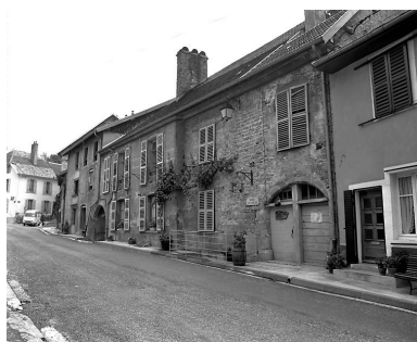
Maison de vigneron située 4 rue sur la Place. Phot. Yves Sancey IVR43_19812500335X
