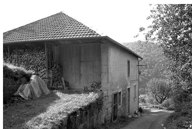
Ferme située rue du Haut. Phot. Yves Sancey IVR43_19802500968X
