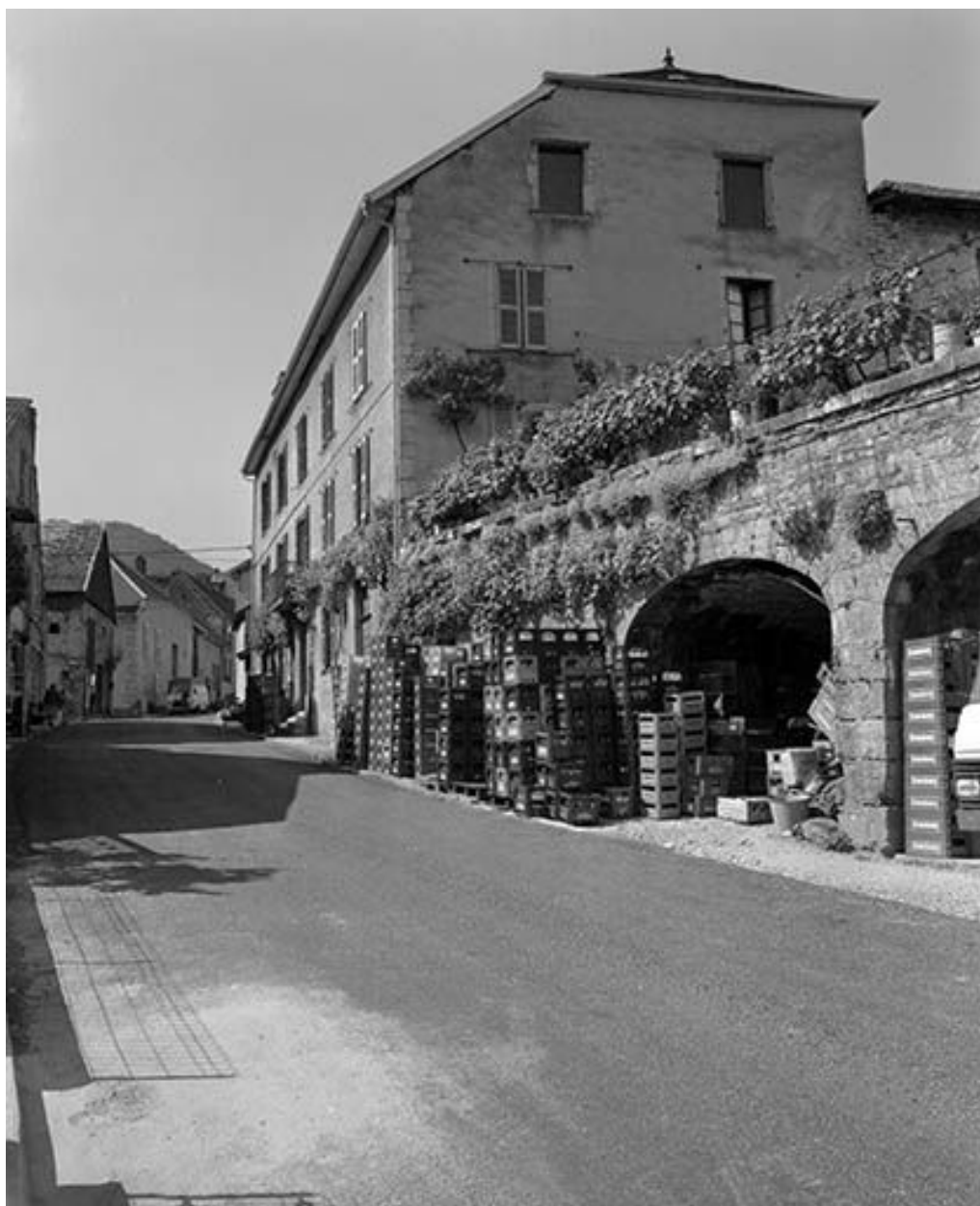
Maison de commerçant située rue du Commandant Vuillemin.
