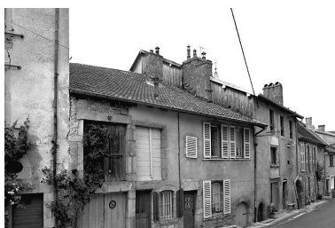
Maison de vigneron située 12 rue sur la Place. Phot. Yves Sancey IVR43_19802500981X
