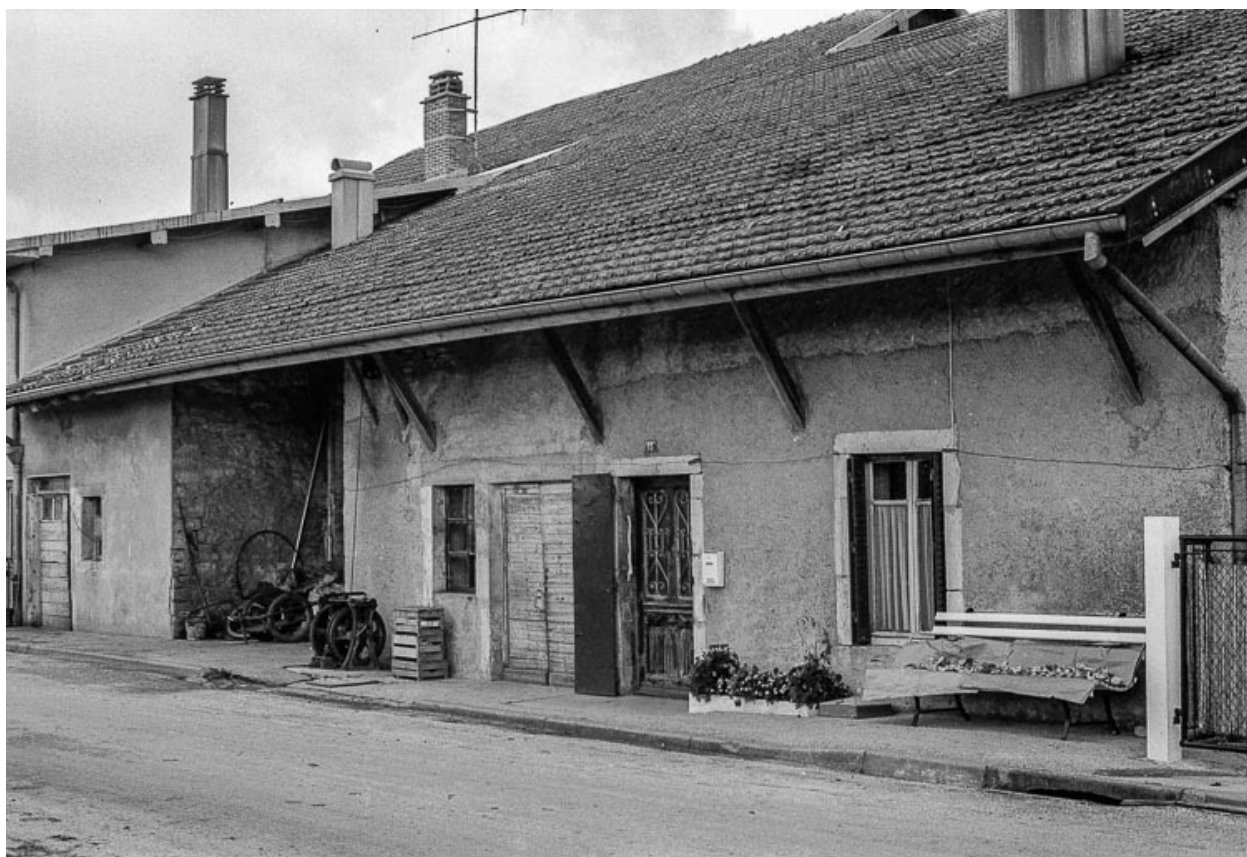
Ferme située 13 rue du Moutet : façade antérieure.
