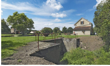
L'aqueduc avec en arrière-plan, la maison éclusière.
