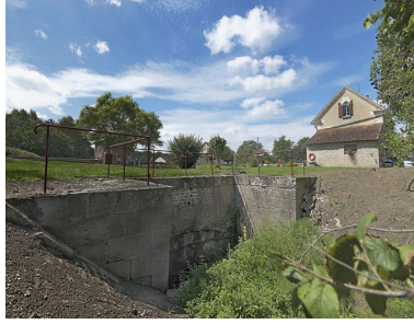
Maçonnerie de l'entrée de l'aqueduc.
