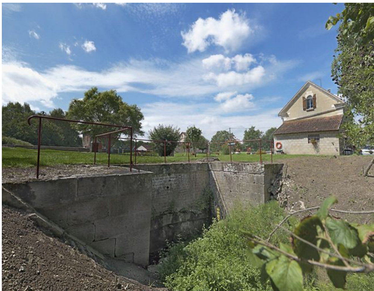
Maçonnerie de l'entrée de l'aqueduc.
