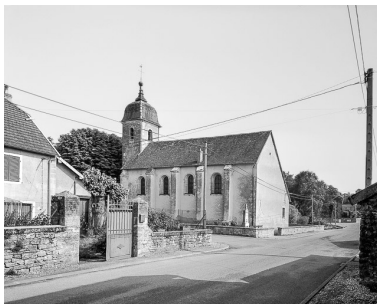
Façade latérale droite et chevet. Phot. Yves Sancey IVR43_19837000138V
