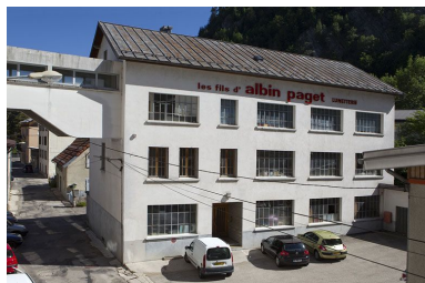
Façade antérieure du bâtiment d'origine, près de la Bienne.
