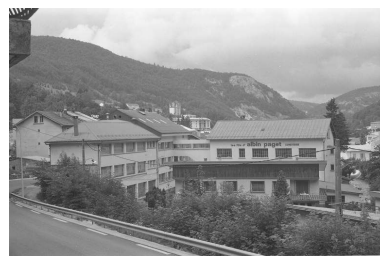
Bâtiments vus du sud.
