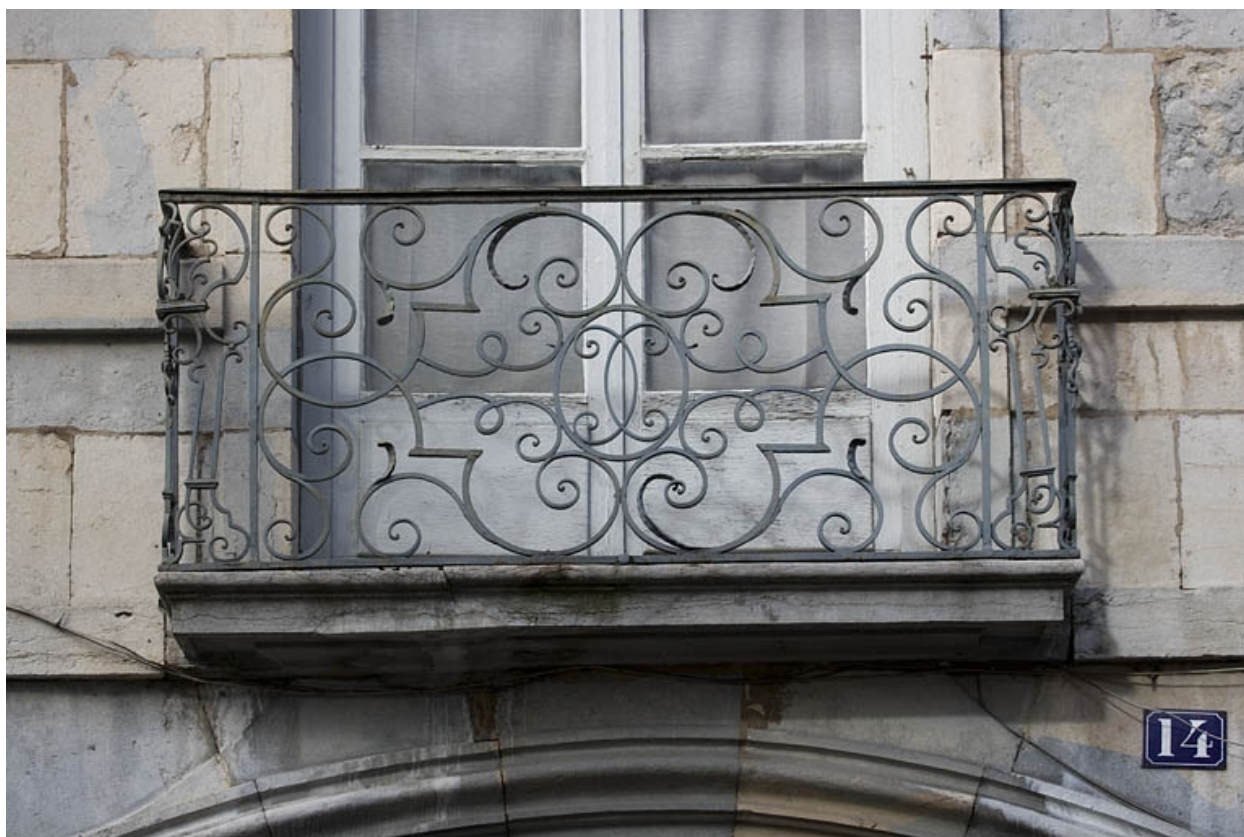
Détail du balcon en fer forgé.
